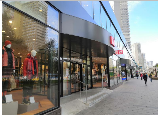
Фотография 3.2. Внешний вид здания
