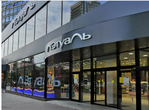
Фотография 3.1. Внешний вид здания
