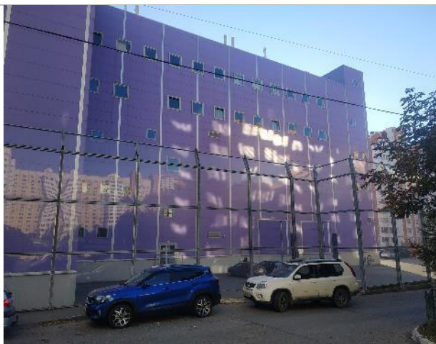
Фотография 59. Здание ТРЦ Карнавал. Фасад здания.
