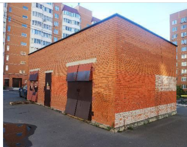
Фотография 77. Здание трансформаторной подстанции.
