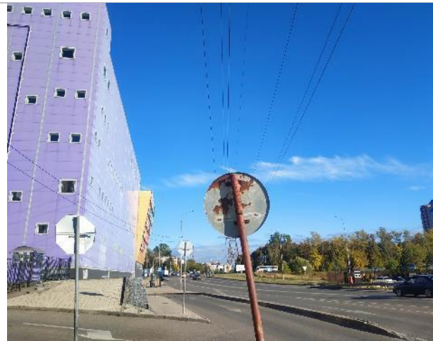
Фотография 63. Здание ТРЦ Карнавал. Фасад здания.
