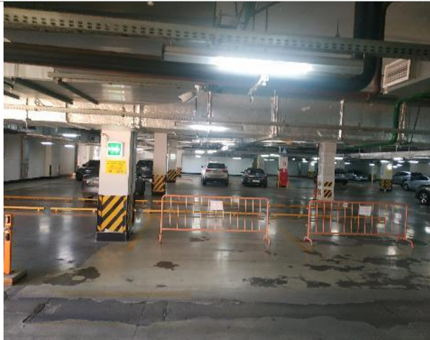
Фотография 43. Здание ТРЦ Карнавал. Паркинг.
