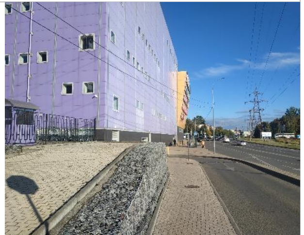
Фотография 64. Здание ТРЦ Карнавал. Фасад здания.
