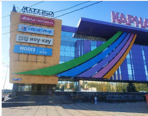
Фотография 70. Здание ТРЦ Карнавал. Фасад здания.
