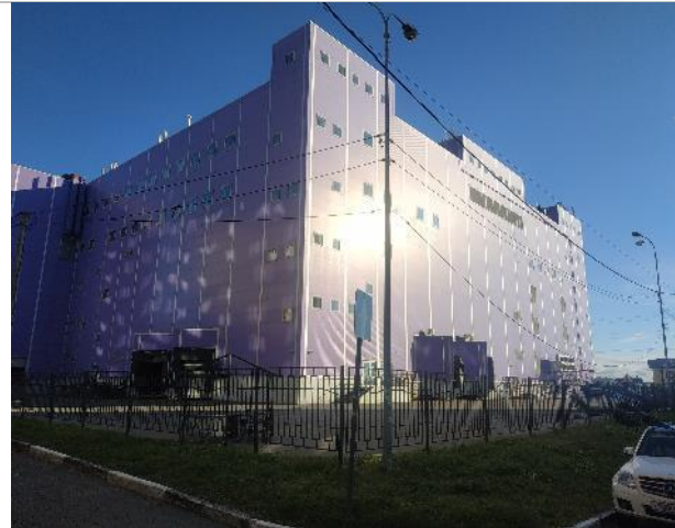
Фотография 61. Здание ТРЦ Карнавал. Фасад здания.
