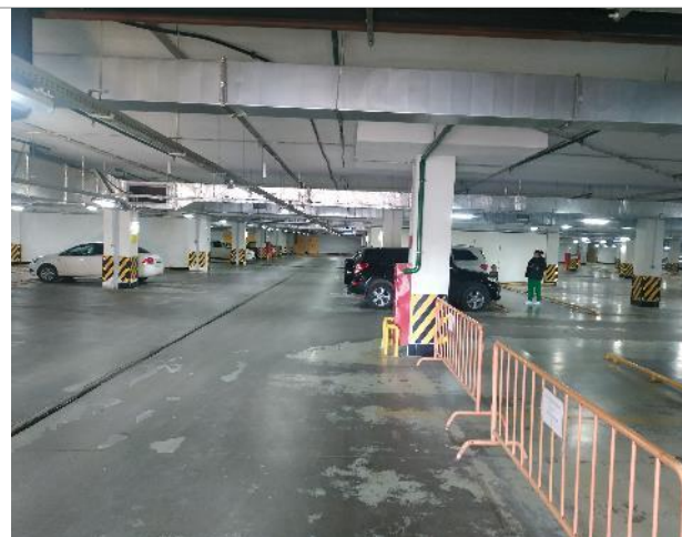
Фотография 41. Здание ТРЦ Карнавал. Паркинг.
