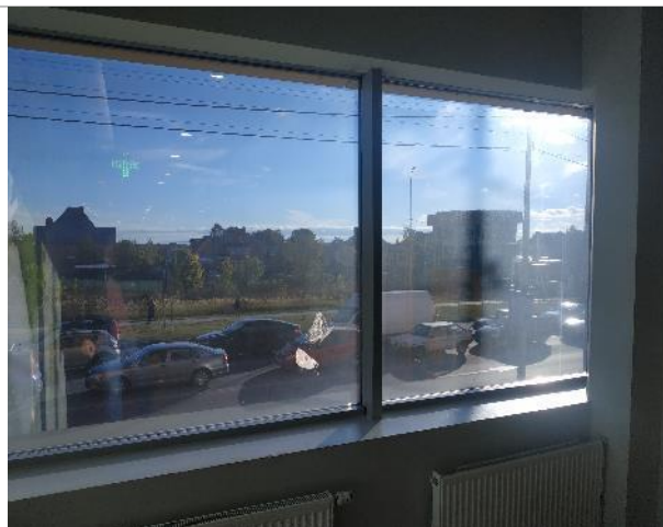
Фотография 40. Здание ТРЦ Карнавал. Внутренние помещения.
