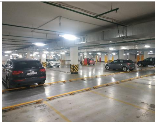
Фотография 48. Здание ТРЦ Карнавал. Паркинг.
