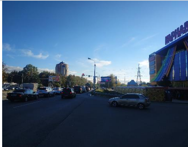
Фотография 56. Здание ТРЦ Карнавал. Фасад здания.
