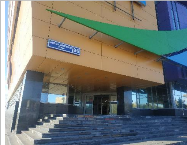
Фотография 67. Здание ТРЦ Карнавал. Фасад здания.
