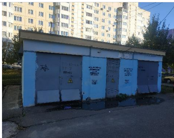
Фотография 76. Здание трансформаторной подстанции.
