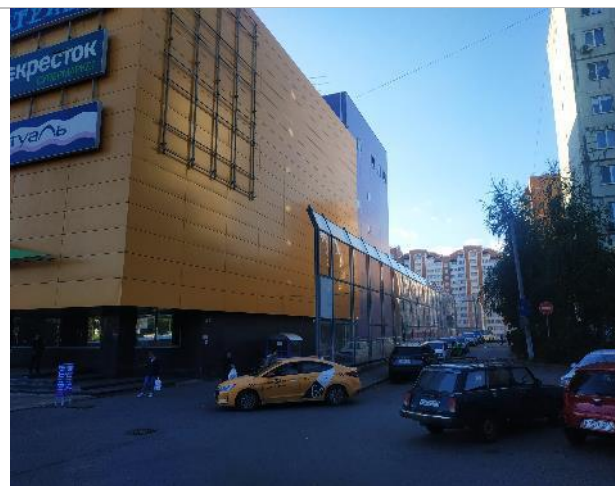
Фотография 51. Здание ТРЦ Карнавал. Фасад здания.
