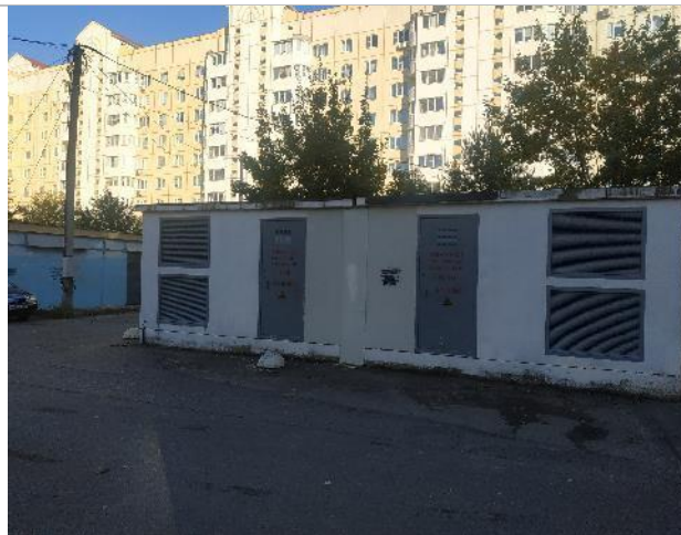
Фотография 72. Здание трансформаторной подстанции.
