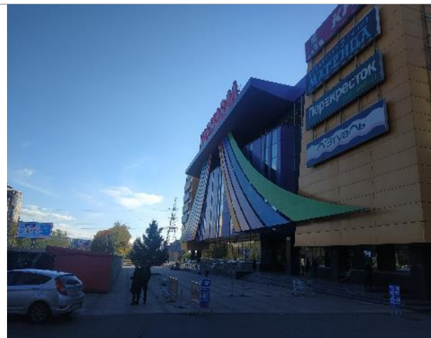
Фотография 53. Здание ТРЦ Карнавал. Фасад здания.
