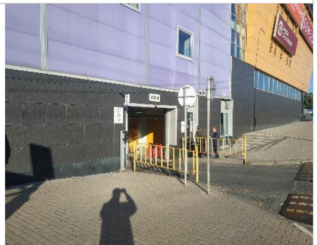
Фотография 66. Здание ТРЦ Карнавал. Фасад здания.
