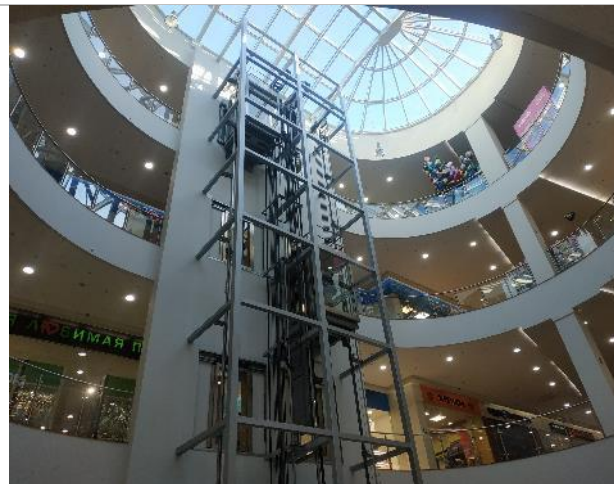
Фотография 12. Здание ТРЦ Карнавал. Внутренние помещения.
