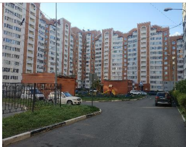
Фотография 78. Здание трансформаторной подстанции.
