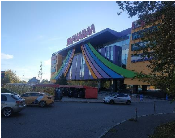
Фотография 57. Здание ТРЦ Карнавал. Фасад здания.
