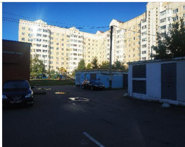
Фотография 74. Здание трансформаторной подстанции.
