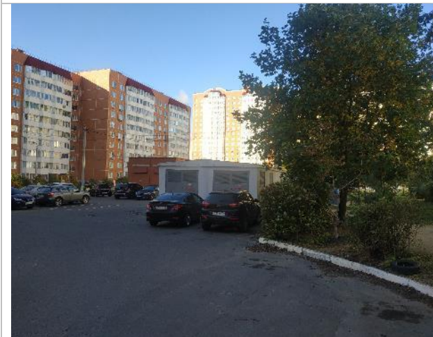
Фотография 71. Здание трансформаторной подстанции.
