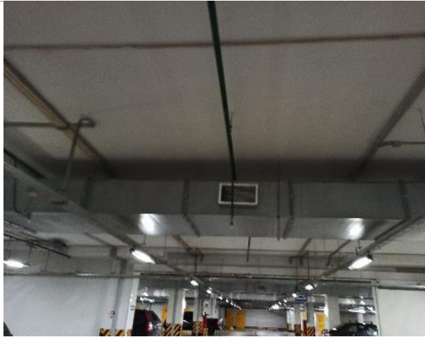
Фото 218. Цокольный этаж объекта оценки.
