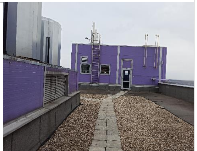
Фото 144. 6 этаж объекта оценки (крыша).
