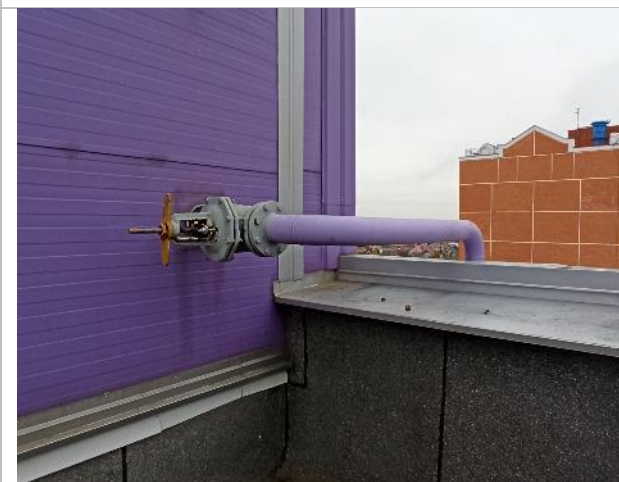
Фото 153. 6 этаж объекта оценки (крыша).
