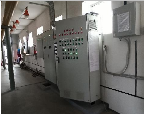
Фото 159. 6 этаж объекта оценки (крыша).
