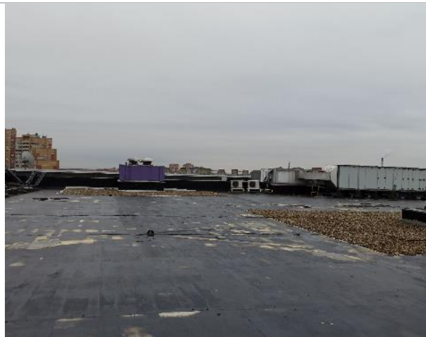
Фото 150. 6 этаж объекта оценки (крыша).
