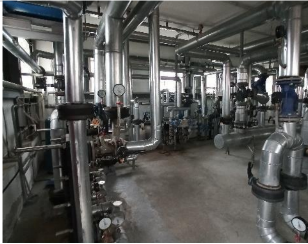
Фото 157. 6 этаж объекта оценки (крыша).
