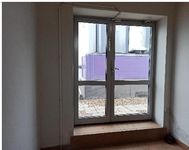
Фото 143. 6 этаж объекта оценки (крыша).
