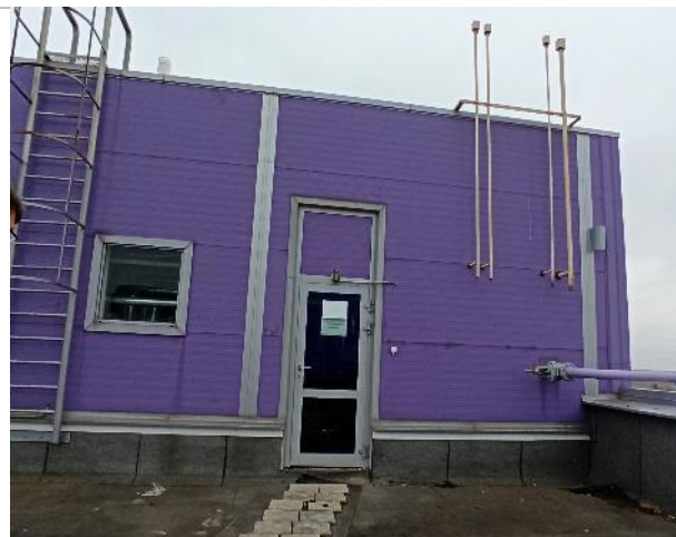
Фото 152. 6 этаж объекта оценки (крыша).
