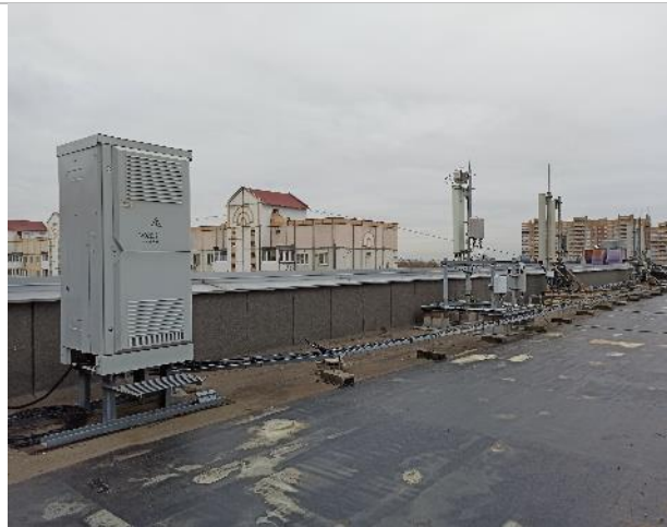
Фото 148. 6 этаж объекта оценки (крыша).
