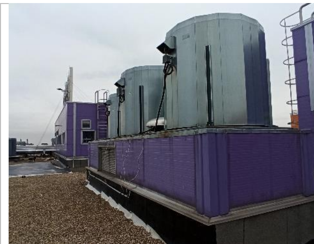
Фото 151. 6 этаж объекта оценки (крыша).
