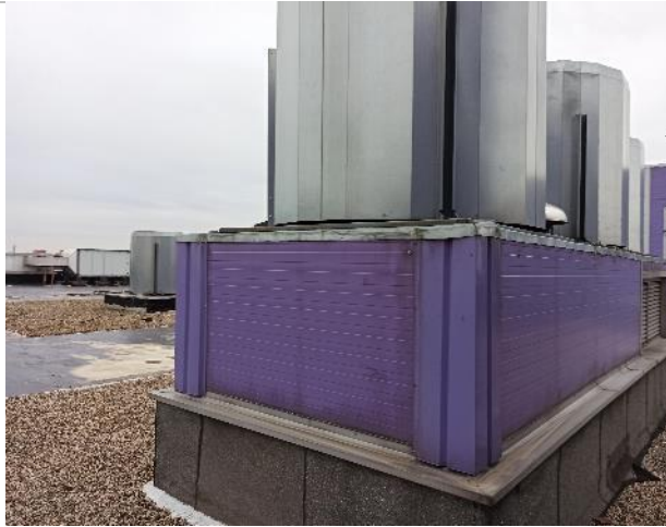
Фото 145. 6 этаж объекта оценки (крыша).
