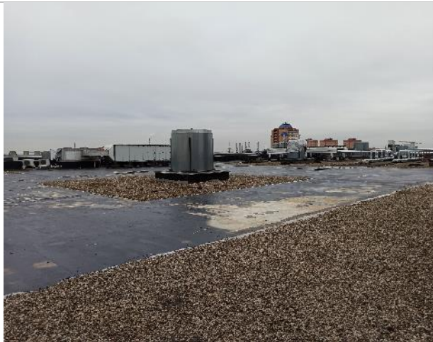
Фото 147. 6 этаж объекта оценки (крыша).
