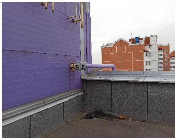
Фото 165. 6 этаж объекта оценки (крыша).
