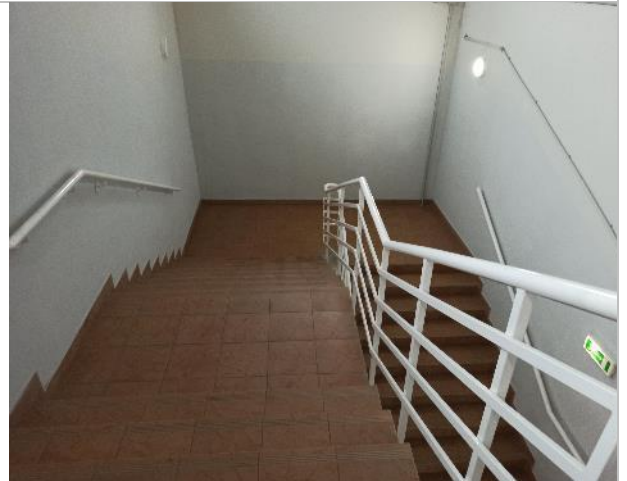
Фото 142. 6 этаж объекта оценки (крыша).
