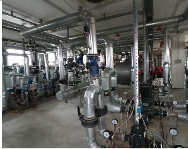
Фото 158. 6 этаж объекта оценки (крыша).
