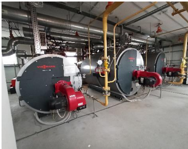
Фото 161. 6 этаж объекта оценки (крыша).
