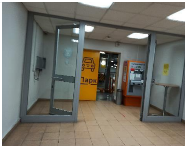
Фото 206. Цокольный этаж объекта оценки.
