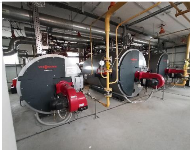
Фото 162. 6 этаж объекта оценки (крыша).
