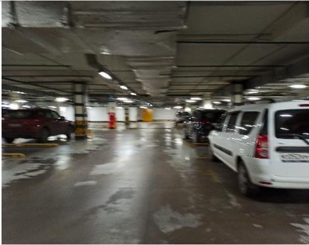
Фото 217. Цокольный этаж объекта оценки.
