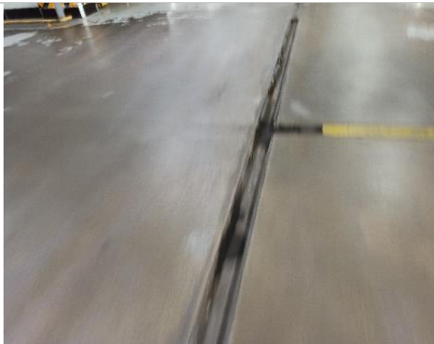
Фото 222. Цокольный этаж объекта оценки.
