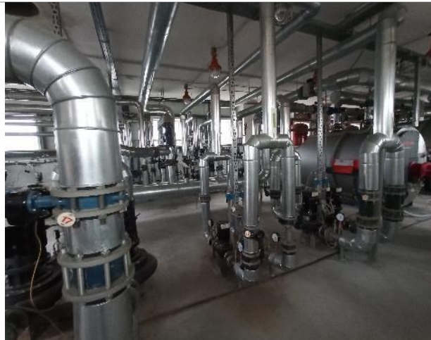
Фото 160. 6 этаж объекта оценки (крыша).
