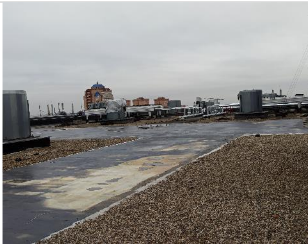
Фото 149. 6 этаж объекта оценки (крыша).
