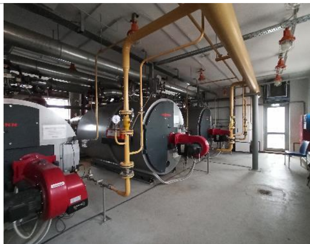
Фото 163. 6 этаж объекта оценки (крыша).
