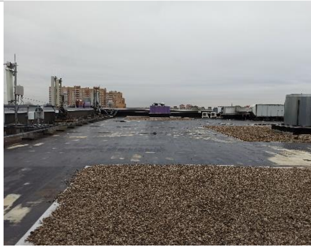
Фото 146. 6 этаж объекта оценки (крыша).
