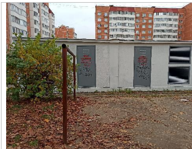
Фотография 3.7. Трансформаторная подстанция (Оцениваемый объект №2)
