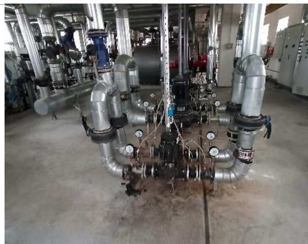
Фото 156. 6 этаж объекта оценки (крыша).
