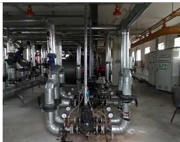
Фото 154. 6 этаж объекта оценки (крыша).
