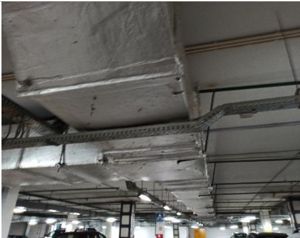
Фото 219. Цокольный этаж объекта оценки.
