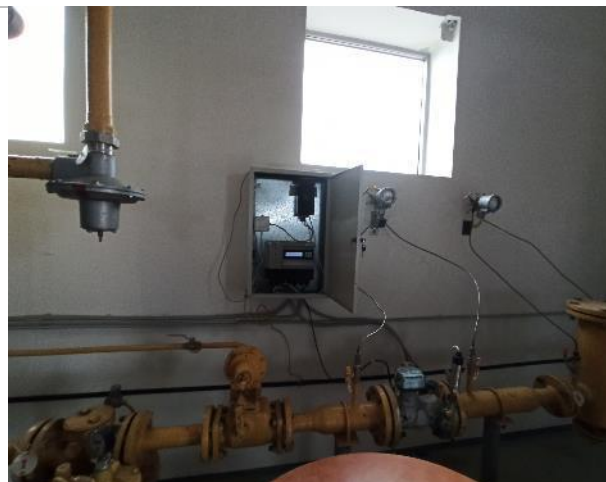
Фото 164. 6 этаж объекта оценки (крыша).
