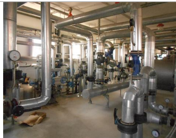
Фото 157. Крыша и тепловой узел.
