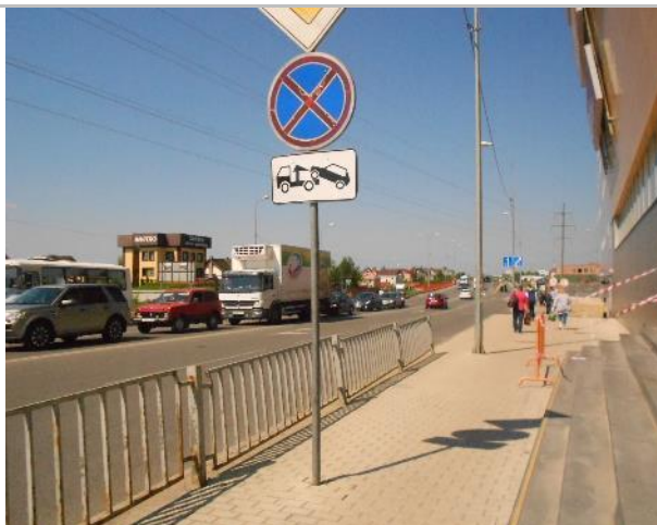
Фото 236. Подъездные пути, прилегающая территория.
