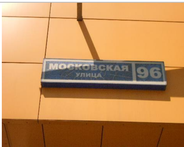
Фото 9. Фасад (оцениваемый объект №1).
