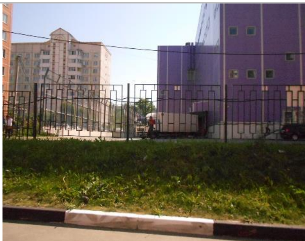
Фото 224. Подъездные пути, прилегающая территория.
