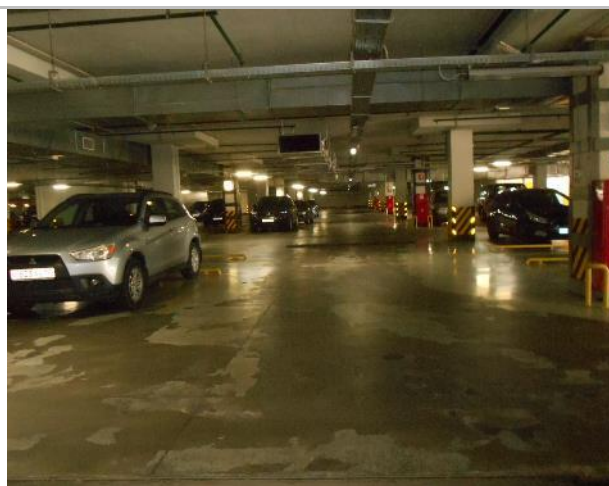
Фото 184. Подз. паркинг и тех. помещения.
