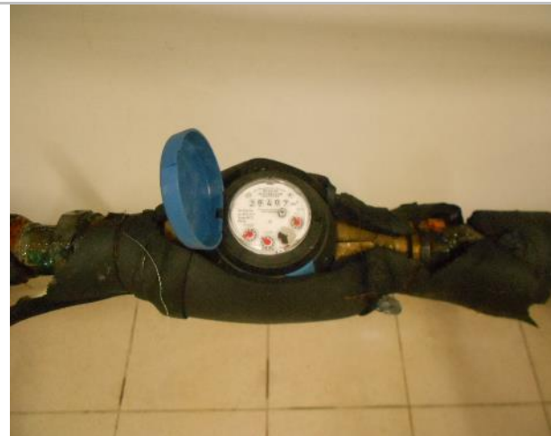
Фото 217. Подз. паркинг и тех. помещения.
