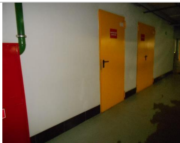
Фото 201. Подз. паркинг и тех. помещения.
