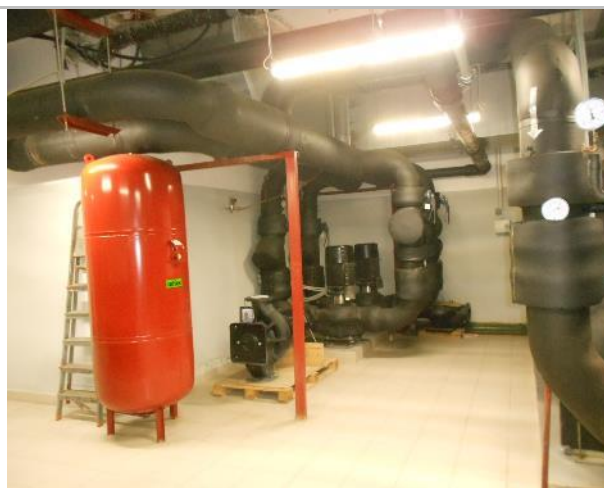
Фото 196. Подз. паркинг и тех. помещения.
