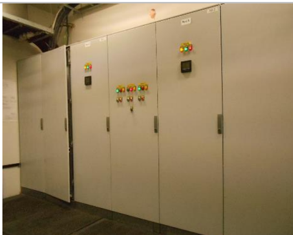
Фото 200. Подз. паркинг и тех. помещения.
