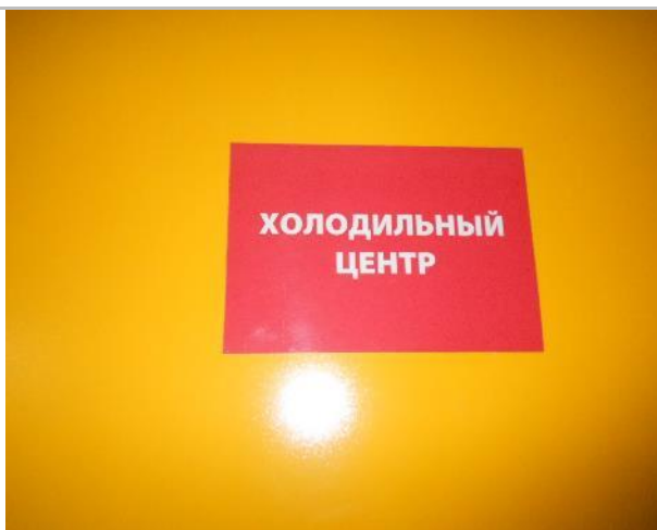
Фото 190. Подз. паркинг и тех. помещения.
