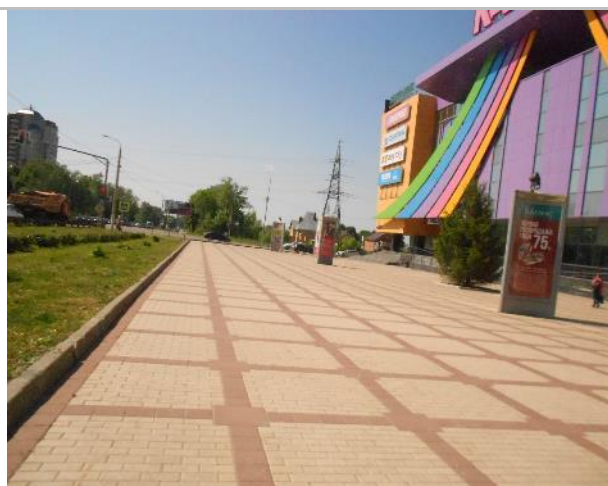
Фото 232. Подъездные пути, прилегающая территория.
