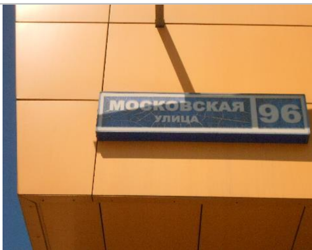
Фото 10. Фасад (оцениваемый объект №1).
