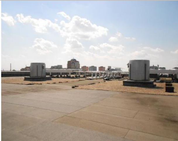
Фото 165. Крыша и тепловой узел.
