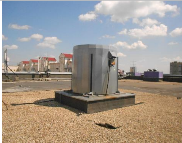
Фото 166. Крыша и тепловой узел.
