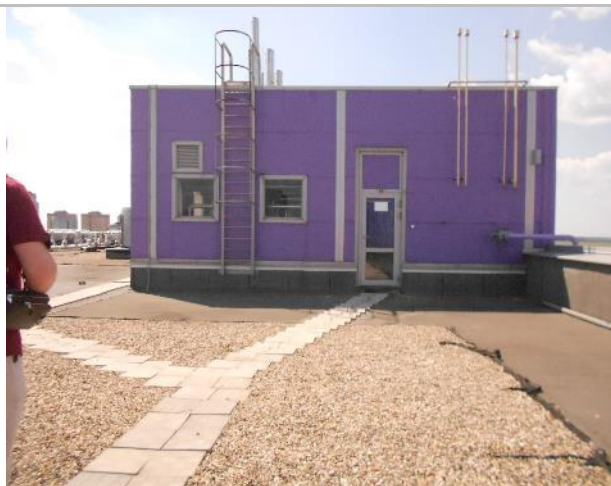
Фото 153. Крыша и тепловой узел.
