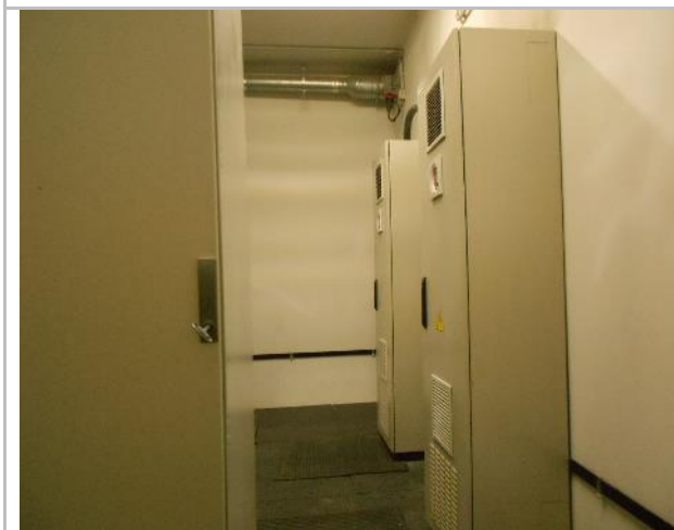
Фото 207. Подз. паркинг и тех. помещения.
