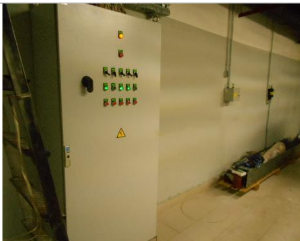
Фото 192. Подз. паркинг и тех. помещения.
