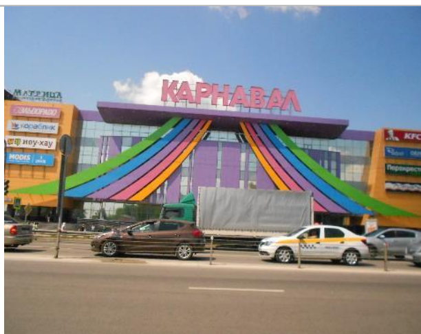
Фото 11. Фасад (оцениваемый объект №1).
