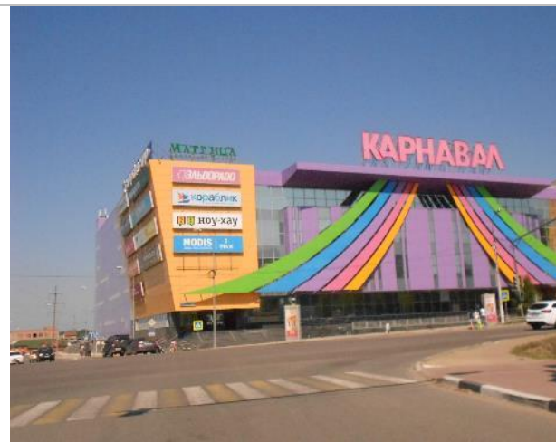
Фото 3. Фасад (оцениваемый объект №1).
