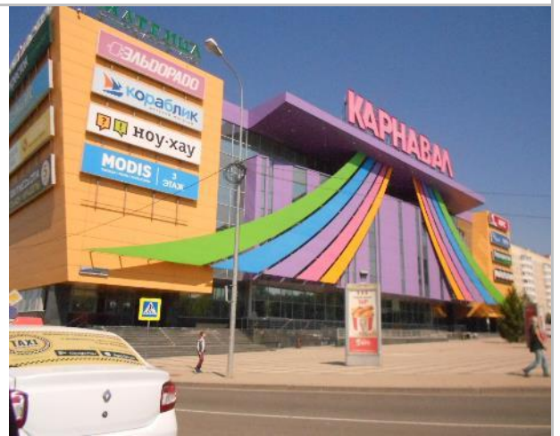
Фото 4. Фасад (оцениваемый объект №1).
