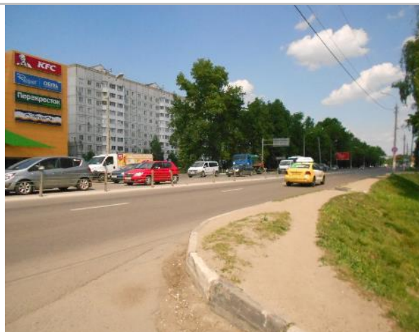
Фото 244. Подъездные пути, прилегающая территория.
