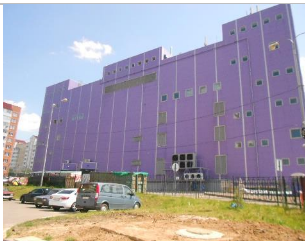
Фото 239. Подъездные пути, прилегающая территория.
