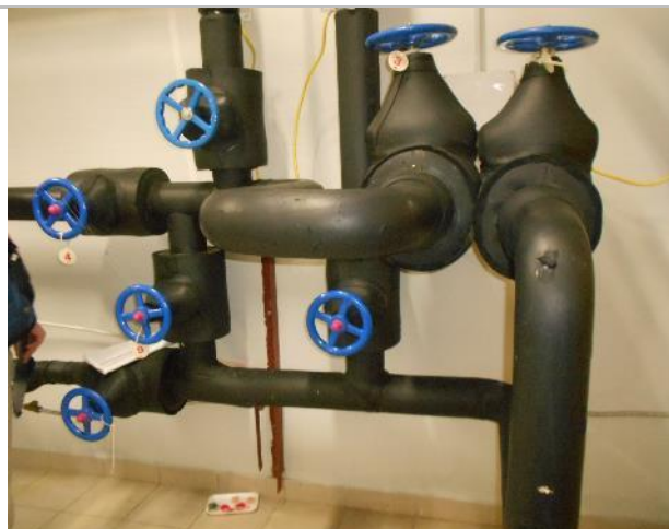
Фото 216. Подз. паркинг и тех. помещения.
