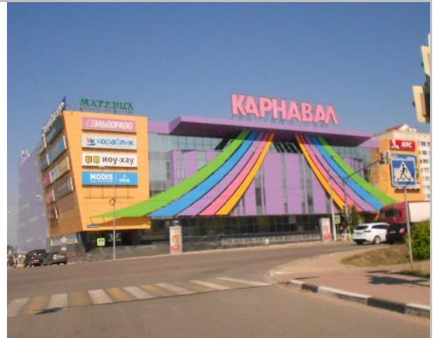
Фото 2. Фасад (оцениваемый объект №1).
