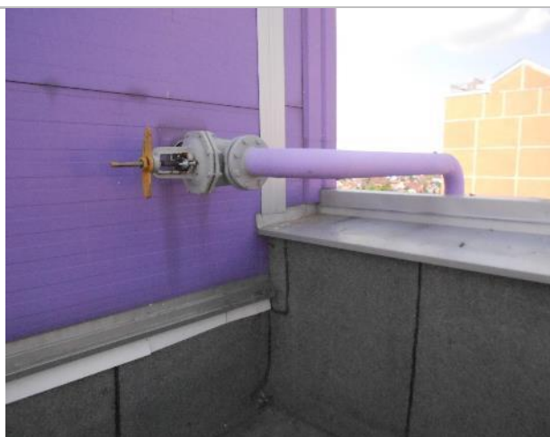
Фото 155. Крыша и тепловой узел.
