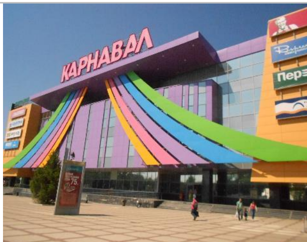
Фото 7. Фасад (оцениваемый объект №1).
