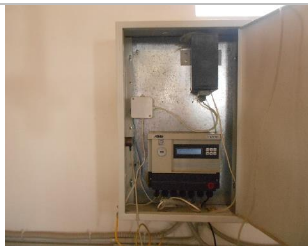
Фото 160. Крыша и тепловой узел.
