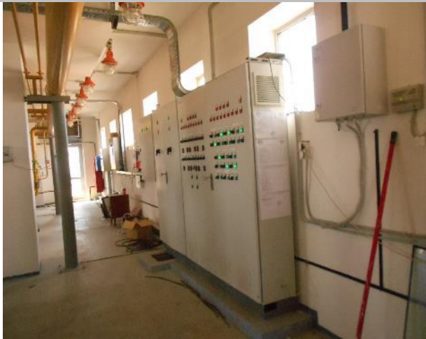
Фото 163. Крыша и тепловой узел.
