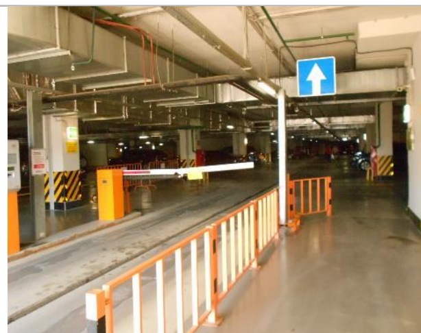
Фото 173. Подз. паркинг и тех. помещения.
