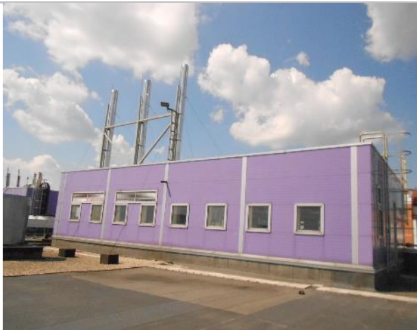
Фото 167. Крыша и тепловой узел.
