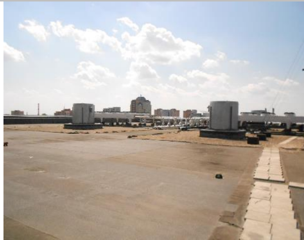
Фото 164. Крыша и тепловой узел.
