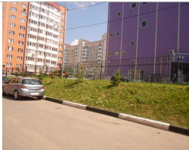
Фото 242. Подъездные пути, прилегающая территория.
