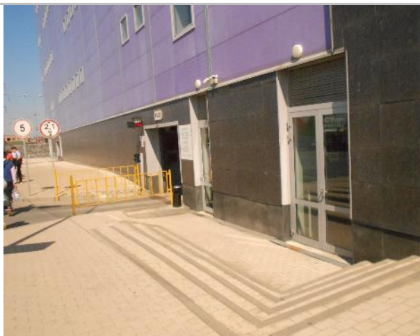
Фото 238. Подъездные пути, прилегающая территория.
