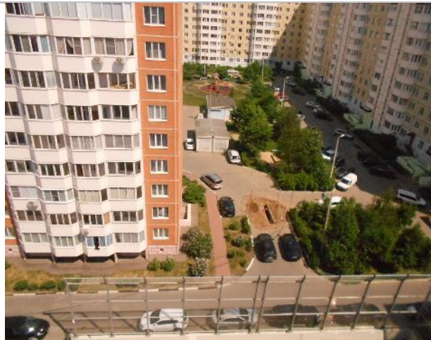
Фото 168. Крыша и тепловой узел.
