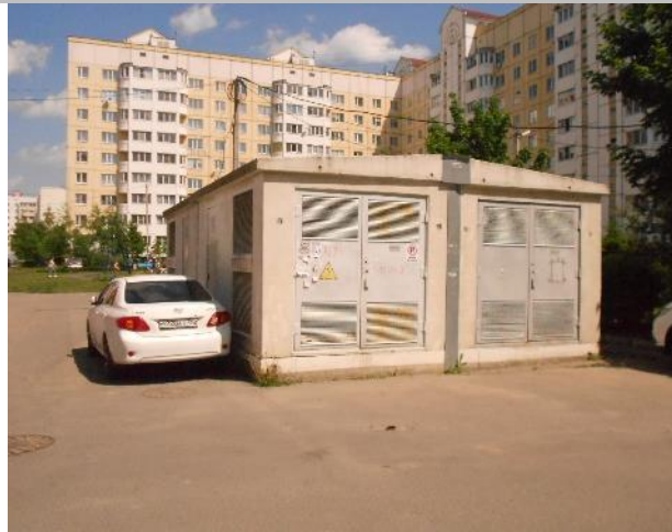
Фото 248. Трансформаторная подстанция (оцениваемый объект №2).
