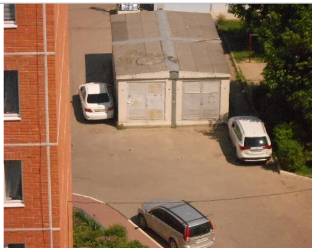
Фото 246. Трансформаторная подстанция (оцениваемый объект №2).
