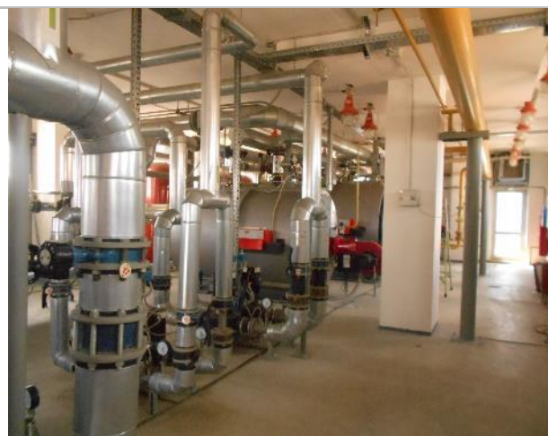
Фото 162. Крыша и тепловой узел.
