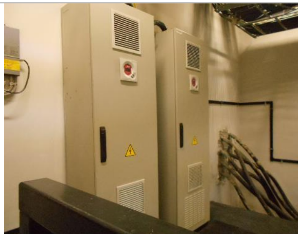
Фото 199. Подз. паркинг и тех. помещения.
