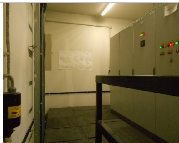
Фото 206. Подз. паркинг и тех. помещения.
