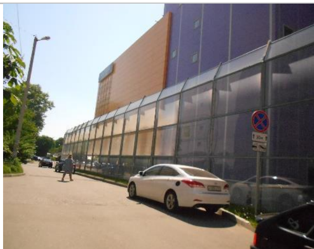
Фото 227. Подъездные пути, прилегающая территория.
