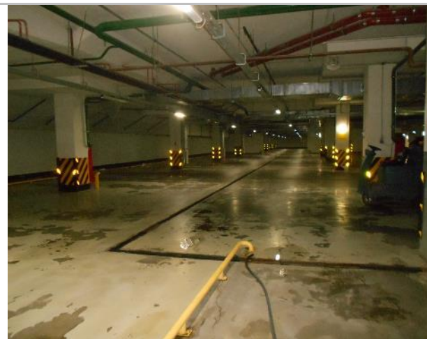
Фото 219. Подз. паркинг и тех. помещения.
