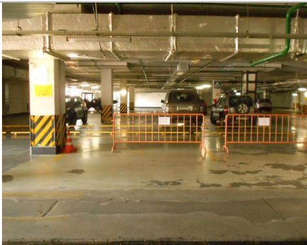
Фото 177. Подз. паркинг и тех. помещения.
