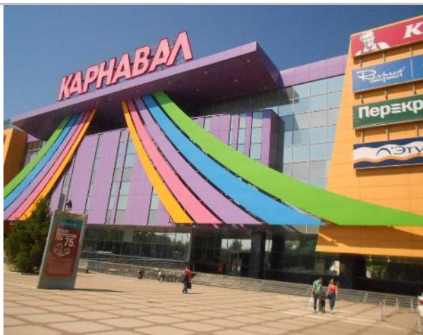
Фото 8. Фасад (оцениваемый объект №1).
