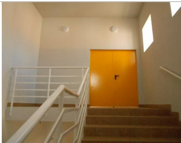
Фото 151. Крыша и тепловой узел.
