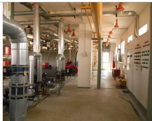
Фото 161. Крыша и тепловой узел.
