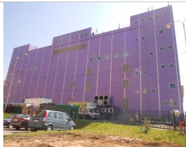
Фото 5. Фасад (оцениваемый объект №1).
