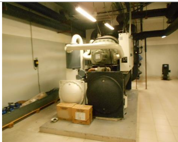
Фото 194. Подз. паркинг и тех. помещения.
