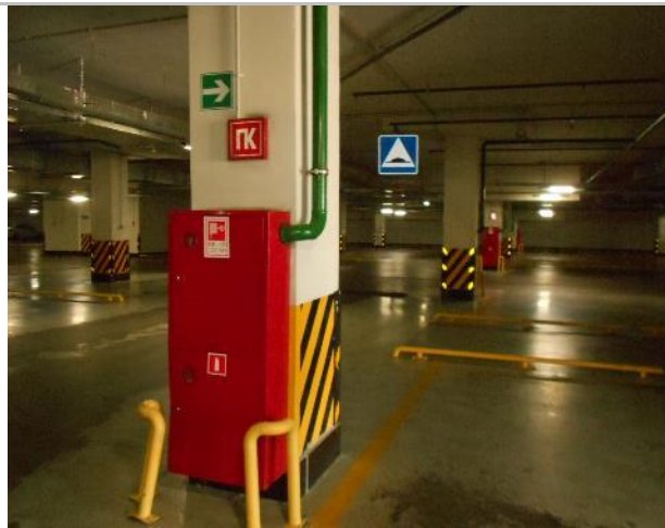
Фото 178. Подз. паркинг и тех. помещения.
