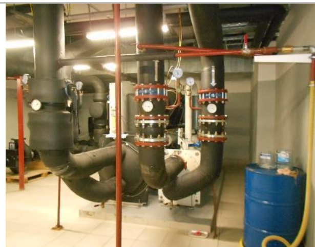
Фото 193. Подз. паркинг и тех. помещения.
