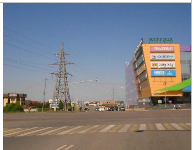
Фото 222. Подъездные пути, прилегающая территория.
