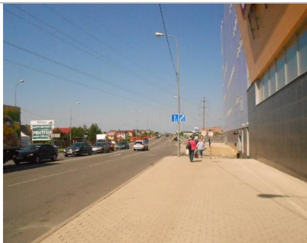
Фото 237. Подъездные пути, прилегающая территория.
