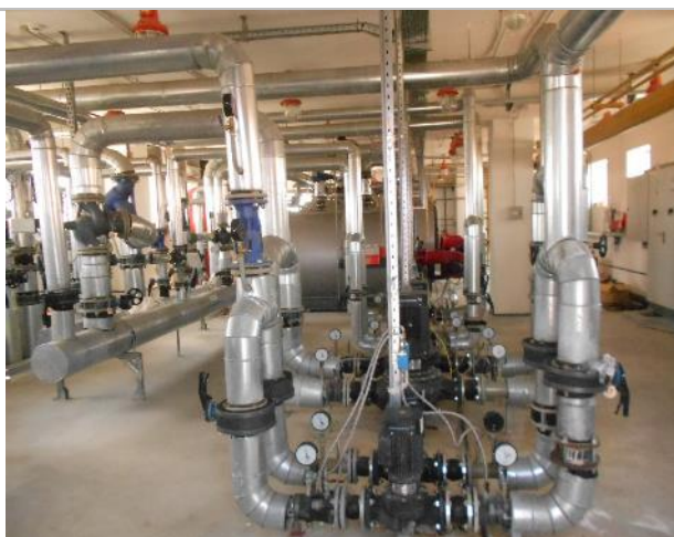
Фото 156. Крыша и тепловой узел.
