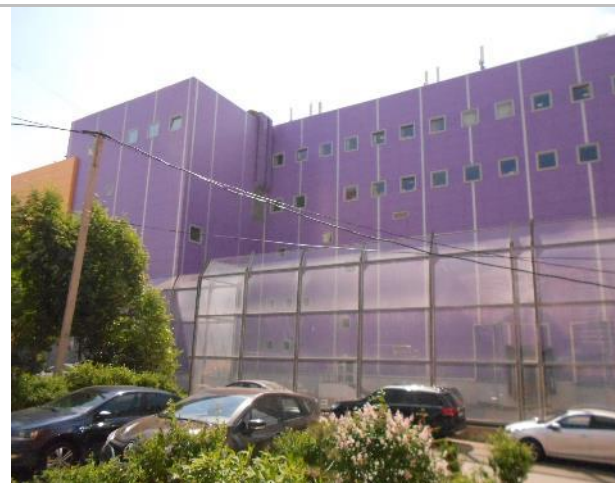
Фото 243. Подъездные пути, прилегающая территория.
