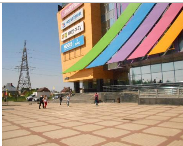
Фото 234. Подъездные пути, прилегающая территория.
