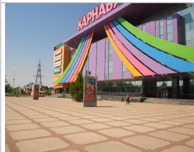
Фото 231. Подъездные пути, прилегающая территория.
