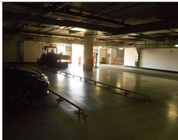
Фото 181. Подз. паркинг и тех. помещения.
