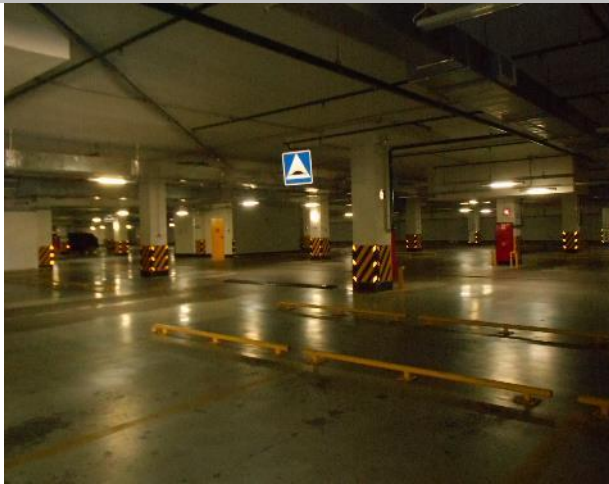
Фото 175. Подз. паркинг и тех. помещения.
