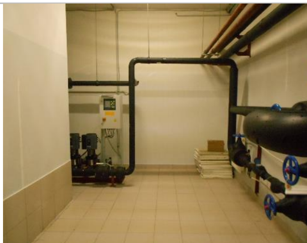
Фото 215. Подз. паркинг и тех. помещения.
