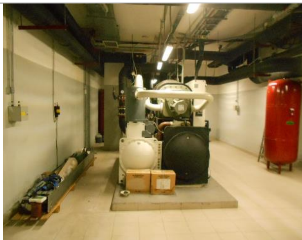
Фото 191. Подз. паркинг и тех. помещения.
