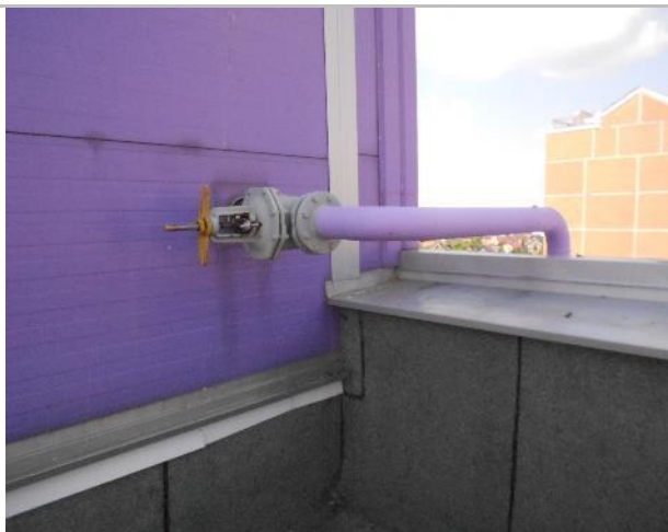
Фото 154. Крыша и тепловой узел.
