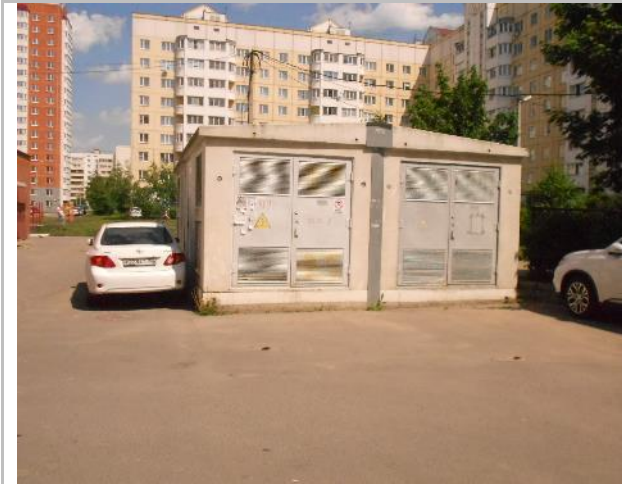
Фото 247. Трансформаторная подстанция (оцениваемый объект №2).
