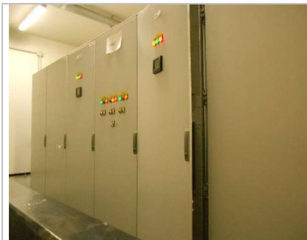
Фото 205. Подз. паркинг и тех. помещения.
