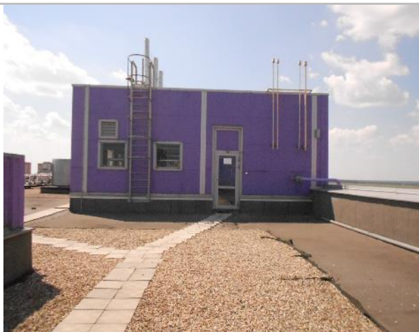
Фото 152. Крыша и тепловой узел.
