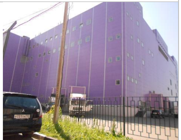
Фото 6. Фасад (оцениваемый объект №1).
