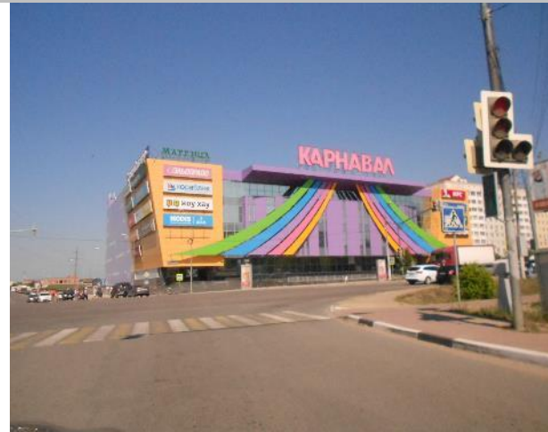
Фото 1. Фасад (оцениваемый объект №1).
