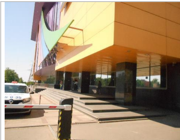
Фото 229. Подъездные пути, прилегающая территория.
