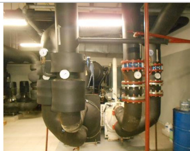
Фото 195. Подз. паркинг и тех. помещения.
