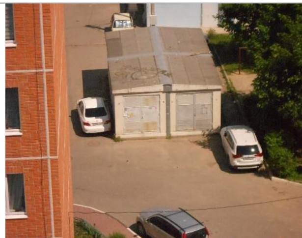
Фото 245. Трансформаторная подстанция (оцениваемый объект №2).
