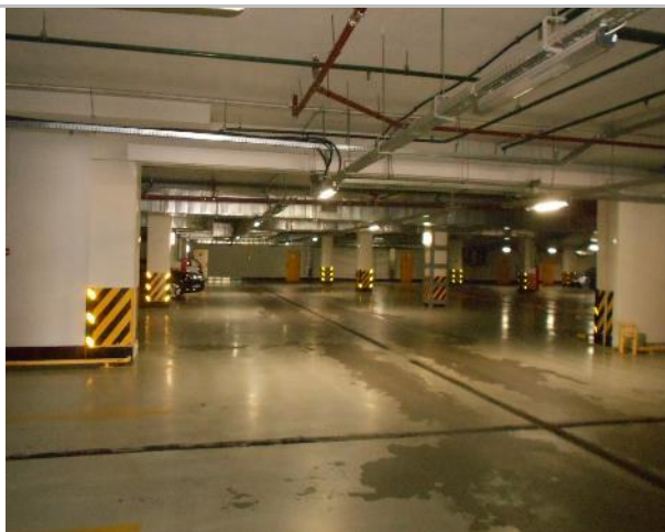
Фото 188. Подз. паркинг и тех. помещения.
