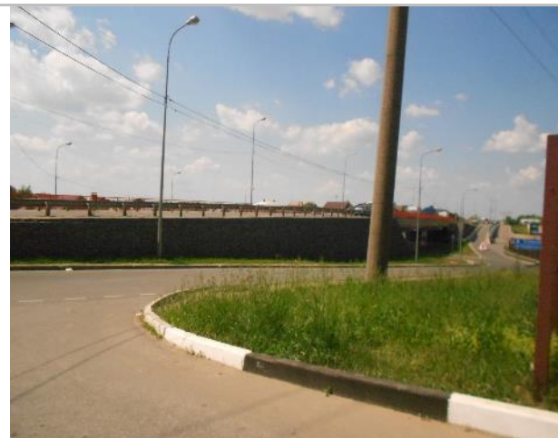
Фото 241. Подъездные пути, прилегающая территория.
