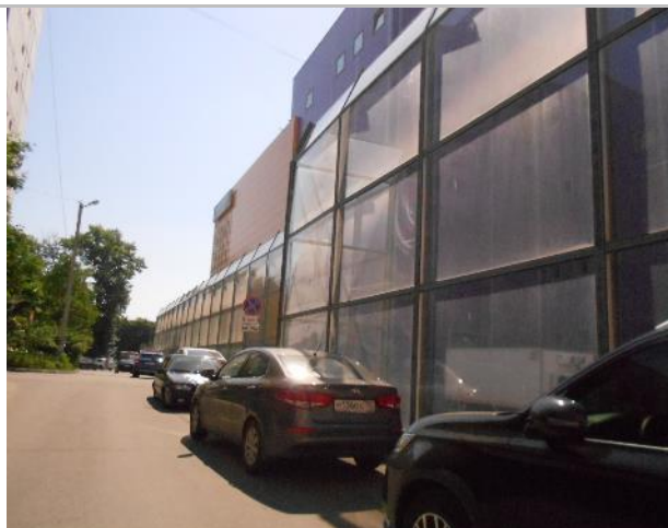
Фото 225. Подъездные пути, прилегающая территория.
