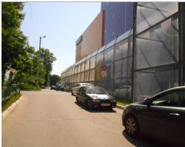
Фото 226. Подъездные пути, прилегающая территория.
