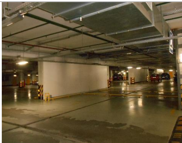
Фото 187. Подз. паркинг и тех. помещения.
