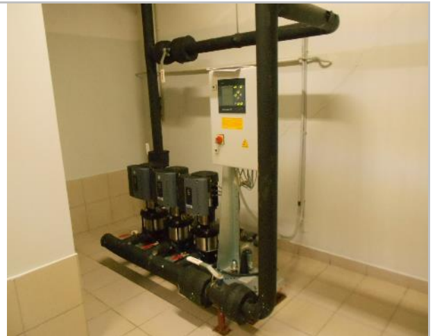
Фото 218. Подз. паркинг и тех. помещения.
