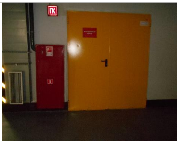
Фото 189. Подз. паркинг и тех. помещения.
