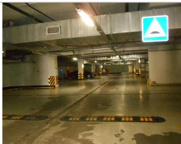
Фото 183. Подз. паркинг и тех. помещения.
