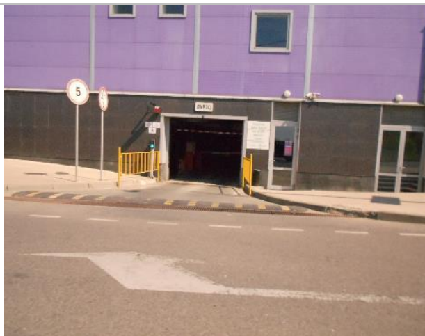
Фото 223. Подъездные пути, прилегающая территория.
