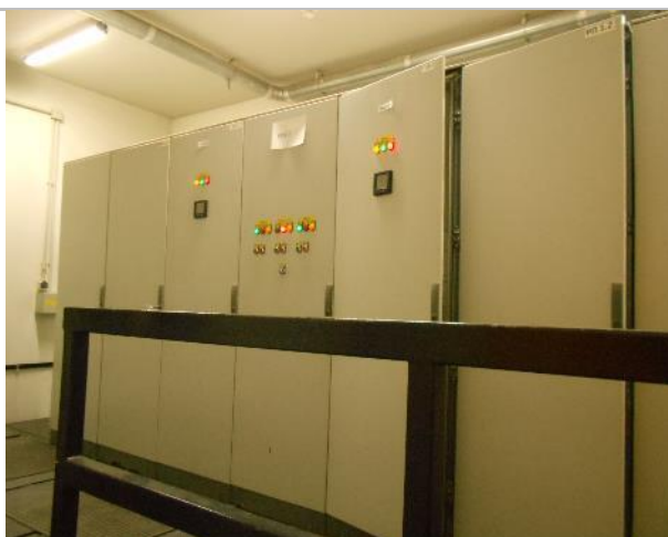
Фото 204. Подз. паркинг и тех. помещения.
