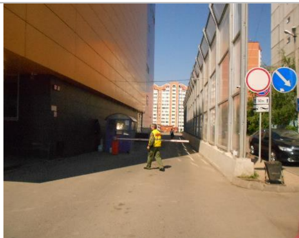
Фото 230. Подъездные пути, прилегающая территория.
