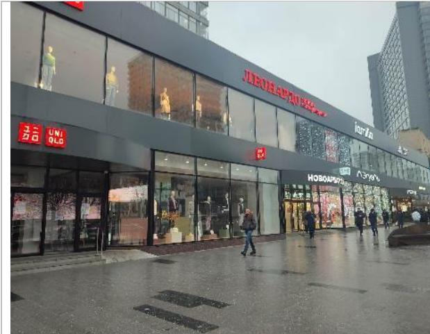
Фото 135. Фасад и прилегающая территория.
