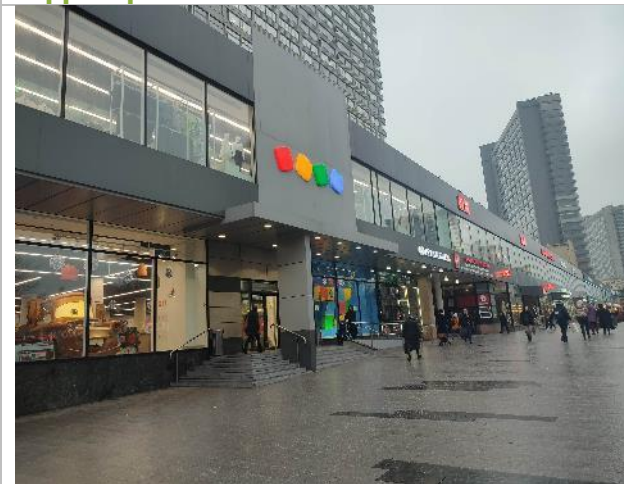
Фото 133. Фасад и прилегающая территория.
