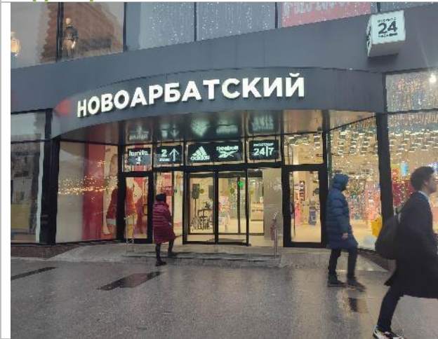
Фото 131. Фасад и прилегающая территория.
