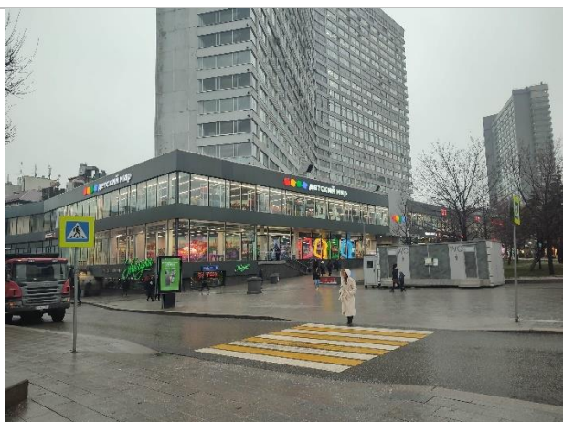
Фотография 3.2. Внешний вид здания
