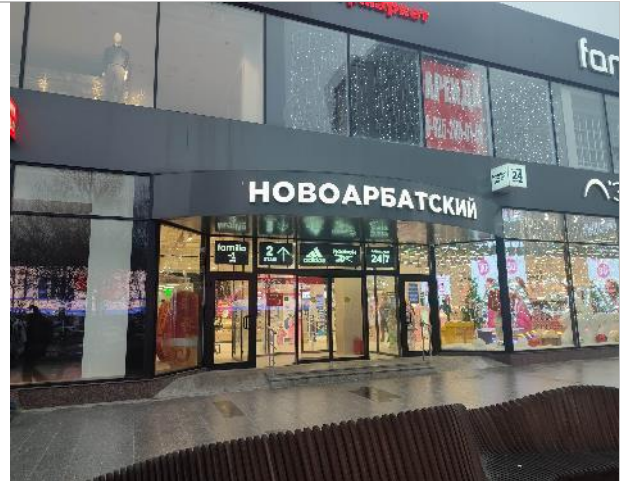
Фото 136. Фасад и прилегающая территория.
