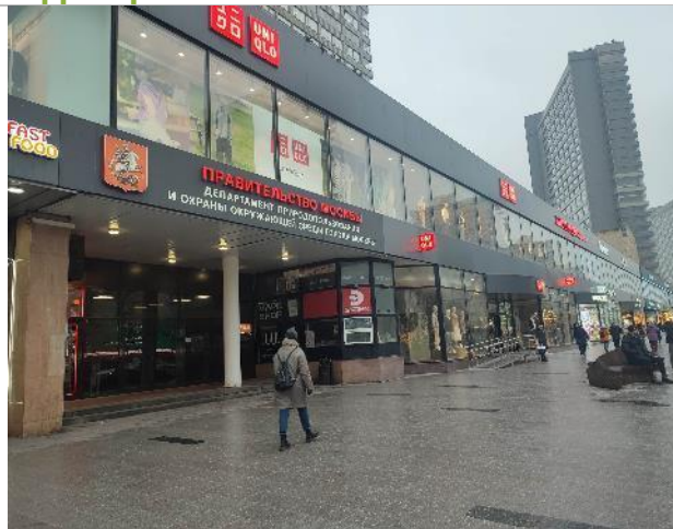
Фото 134. Фасад и прилегающая территория.
