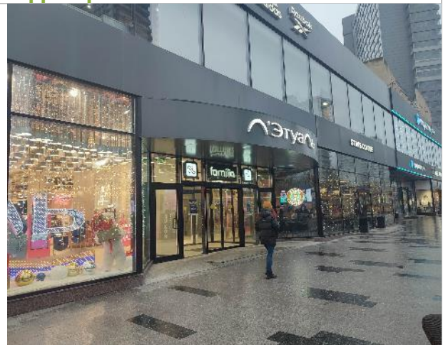
Фото 138. Фасад и прилегающая территория.
