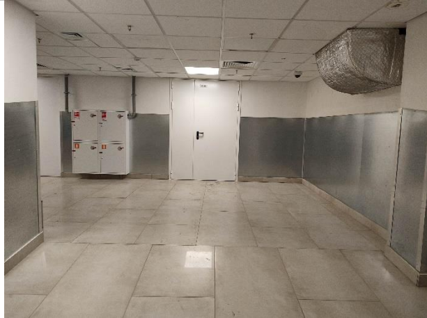
Фотография 3.9. Состояние внутренних помещений
