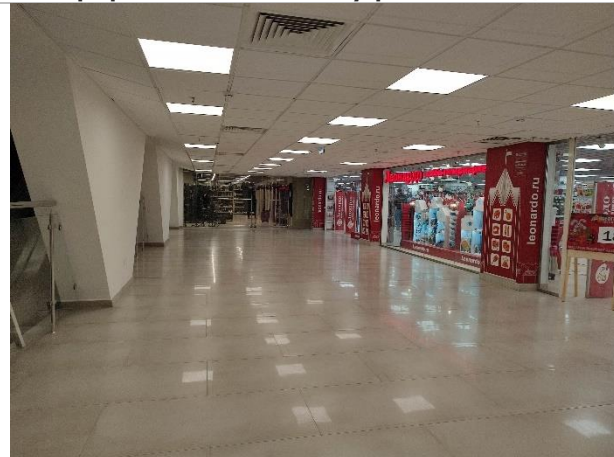
Фотография 3.5. Состояние внутренних помещений
