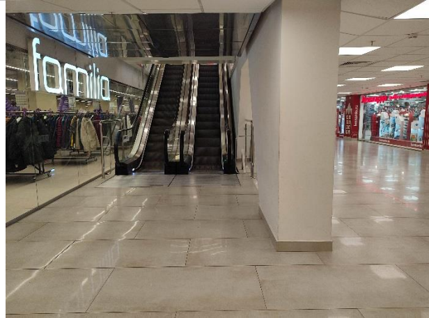
Фотография 3.10. Состояние внутренних помещений
