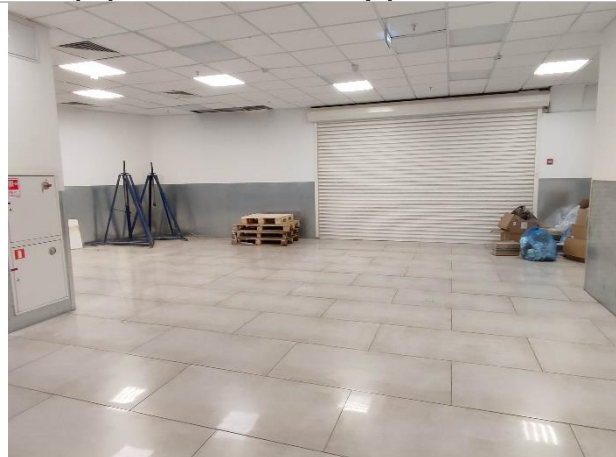
Фотография 3.12. Состояние внутренних помещений
