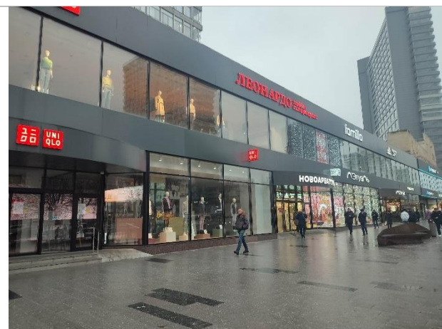
Фотография 3.1. Внешний вид здания
