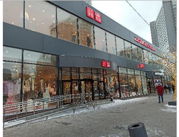
Фотография 212. Фасад здания
