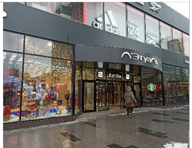
Фотография 216. Фасад здания
