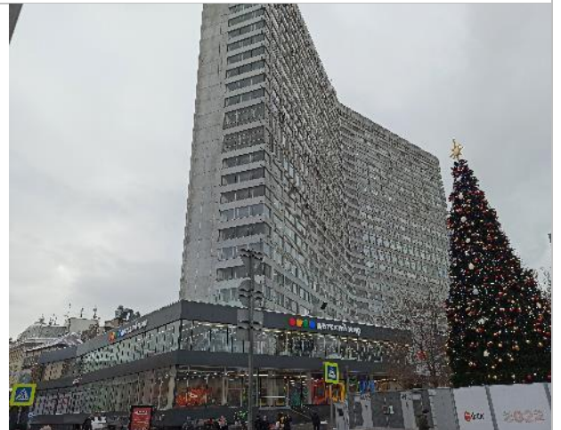
Фотография 202. Фасад здания
