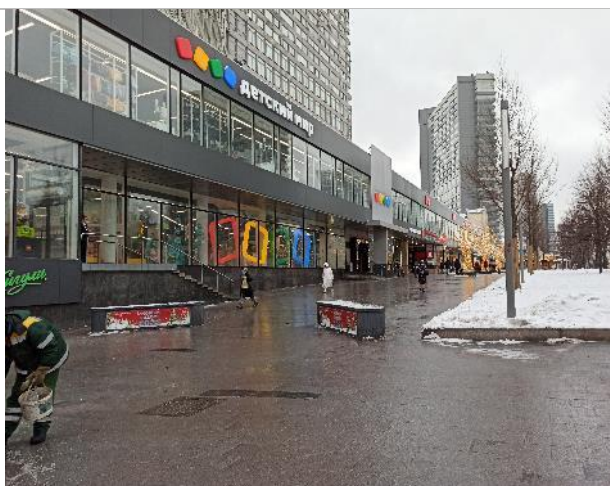
Фотография 208. Фасад здания
