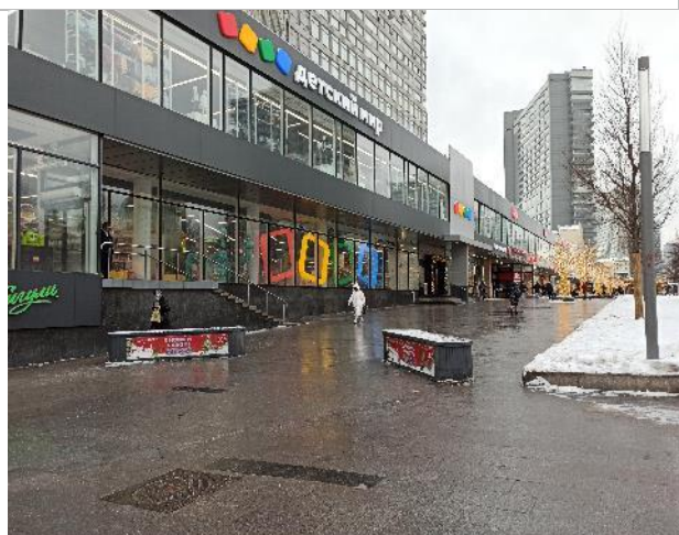
Фотография 209. Фасад здания
