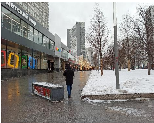
Фотография 210. Фасад здания
