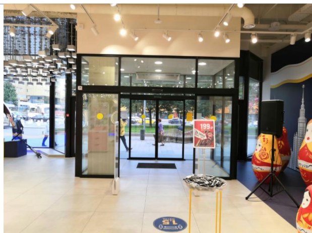
Фотография 3.11. Состояние внутренних помещений
