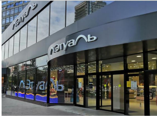
Фотография 3.1. Внешний вид здания
