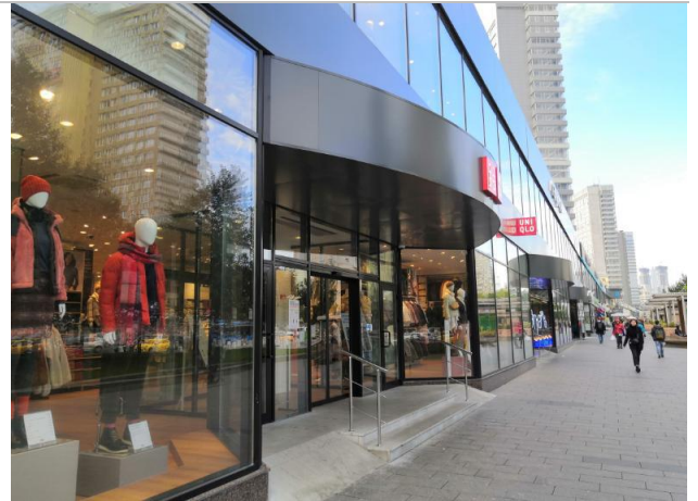
Фотография 3.2. Внешний вид здания
