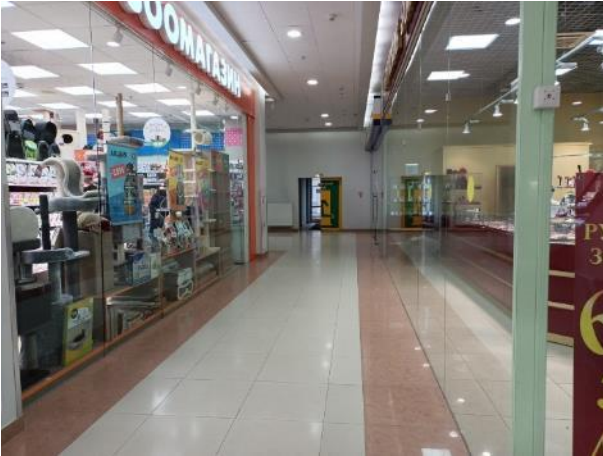
Фото 13. Состояние помещений 1 этажа
