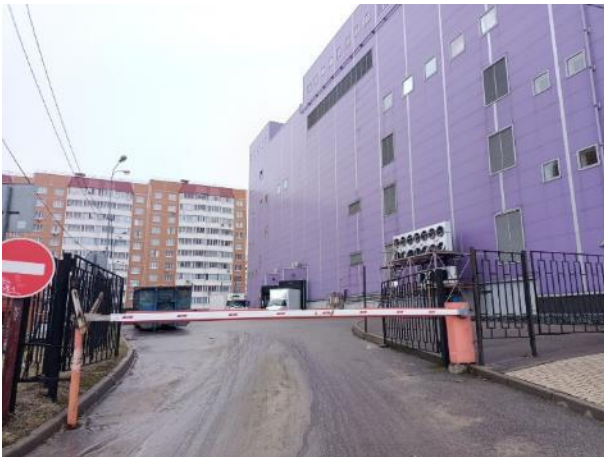
Фото 3. Внешний вид здания
