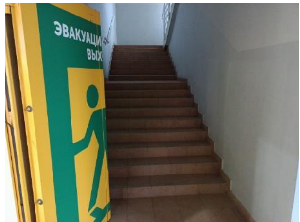
Фото 16. Состояние помещений 1 этажа
