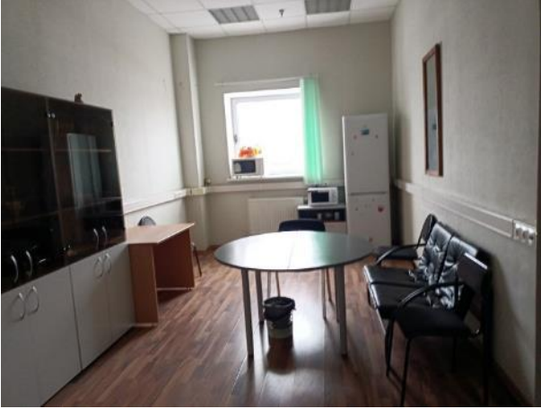
Фото 31. Состояние помещений 5 этажа
