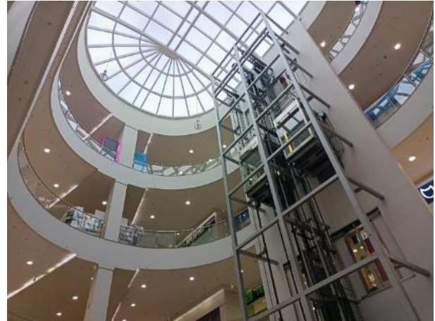
Фото 14. Состояние помещений 1 этажа
