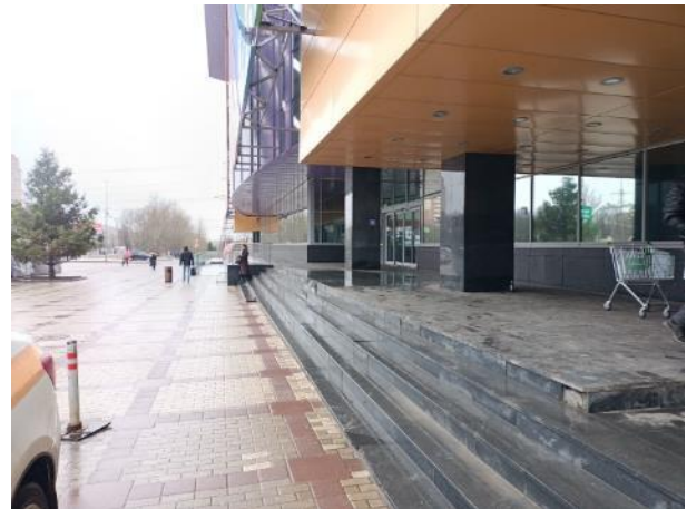
Фото 4. Внешний вид здания
