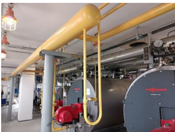
Фото 39. Газопровод -ввод
