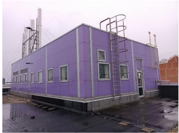
Фото 34. Состояние помещений 6 этажа
