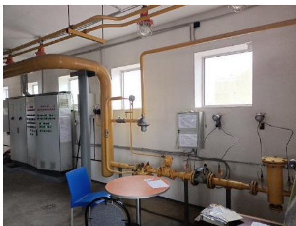
Фото 40. Газопровод -ввод
