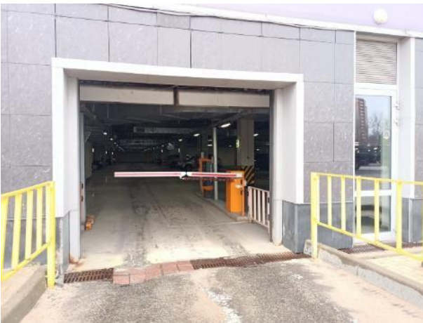
Фото 9. Состояние помещений этажа -1 (въезд)
