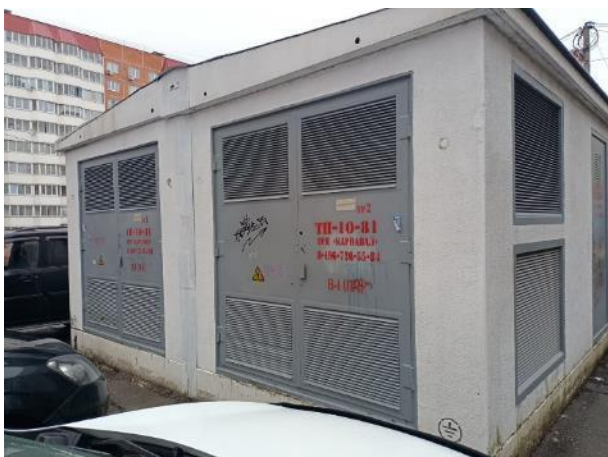
Фото 41. Здание трансформаторной подстанции
