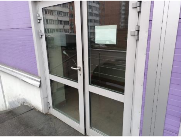
Фото 7. Состояние помещений этажа -1 (Вход)
