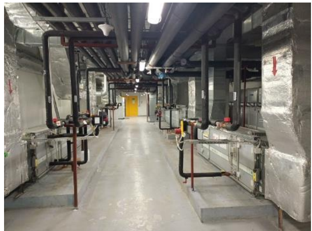
Фото 30. Состояние помещений 5 этажа
