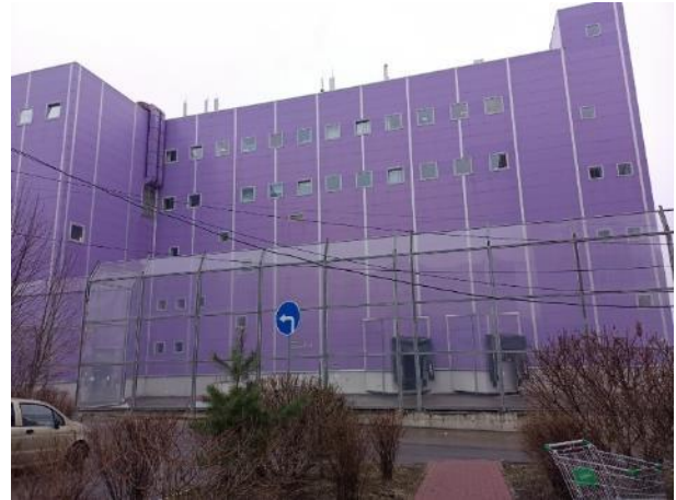
Фото 2. Внешний вид здания
