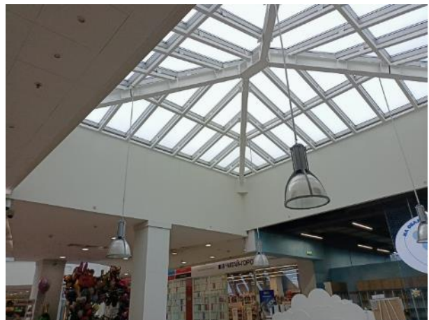
Фото 28. Состояние помещений 4 этажа
