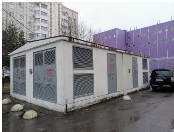
Фото 42. Здание трансформаторной подстанции
