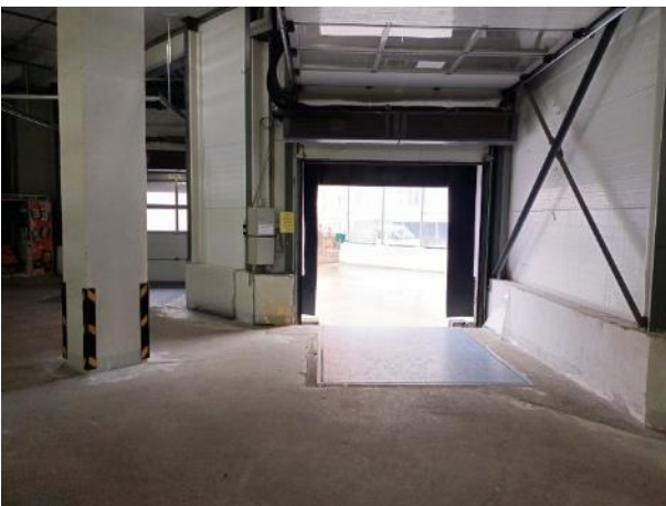
Фото 15. Состояние помещений 1 этажа
