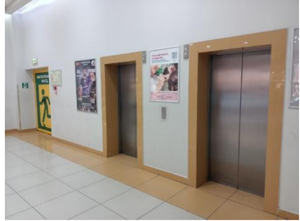
Фото 20. Состояние помещений 2 этажа
