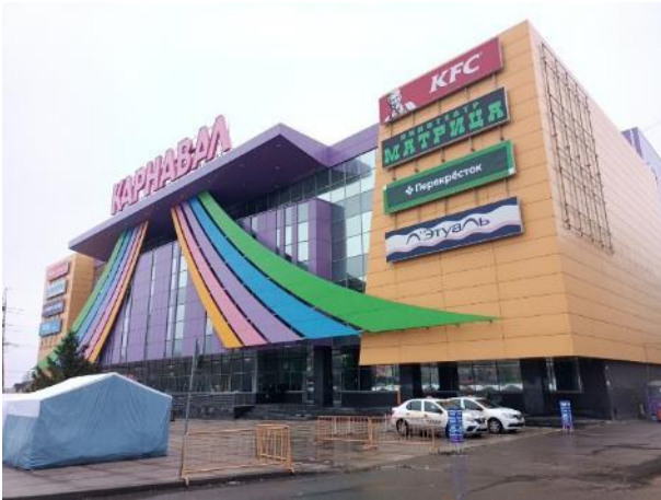
Фото 1. Внешний вид здания
