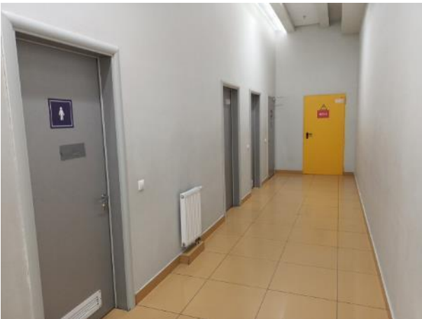
Фото 23. Состояние помещений 3 этажа
