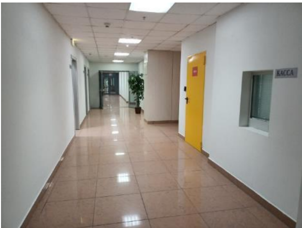
Фото 29. Состояние помещений 5 этажа
