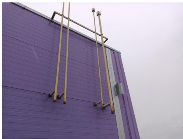
Фото 38. Газопровод -ввод
