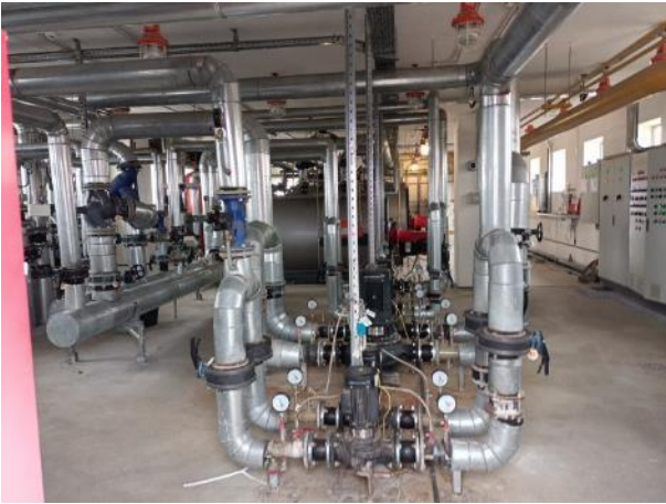
Фото 33. Состояние помещений 6 этажа
