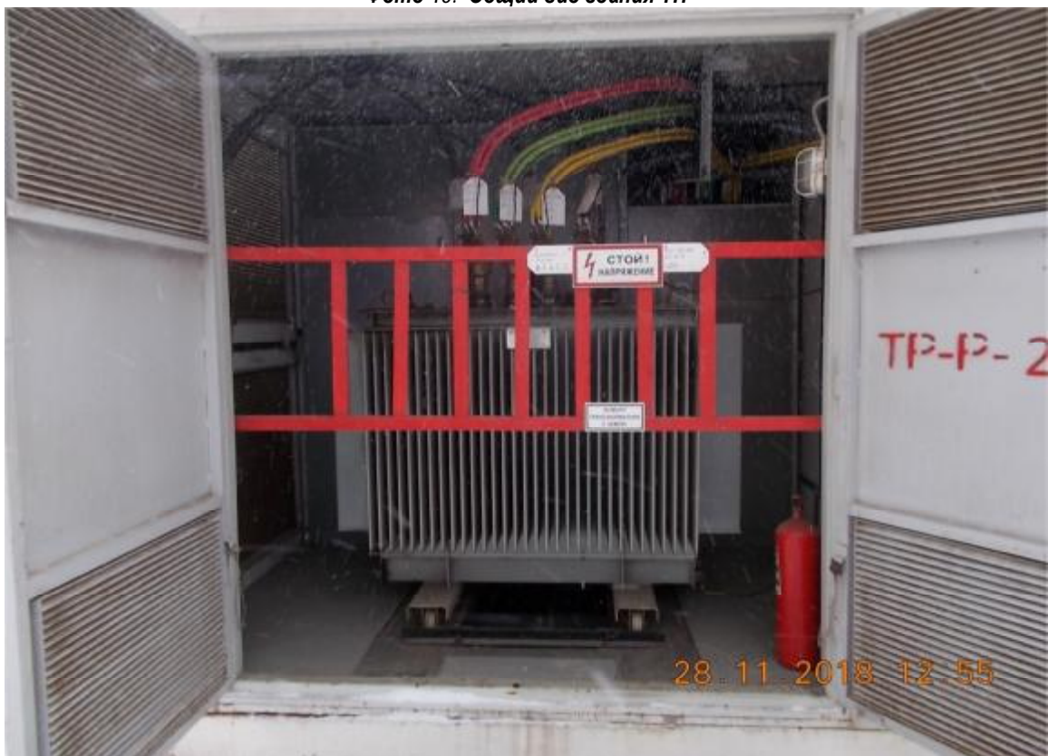
Фото 11. Общий вид здания ТП
