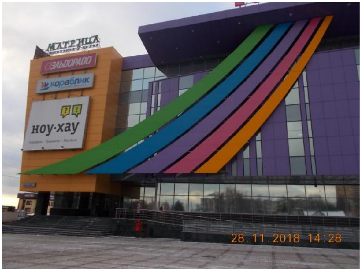
Фото 2. Лицевой фасад здания
