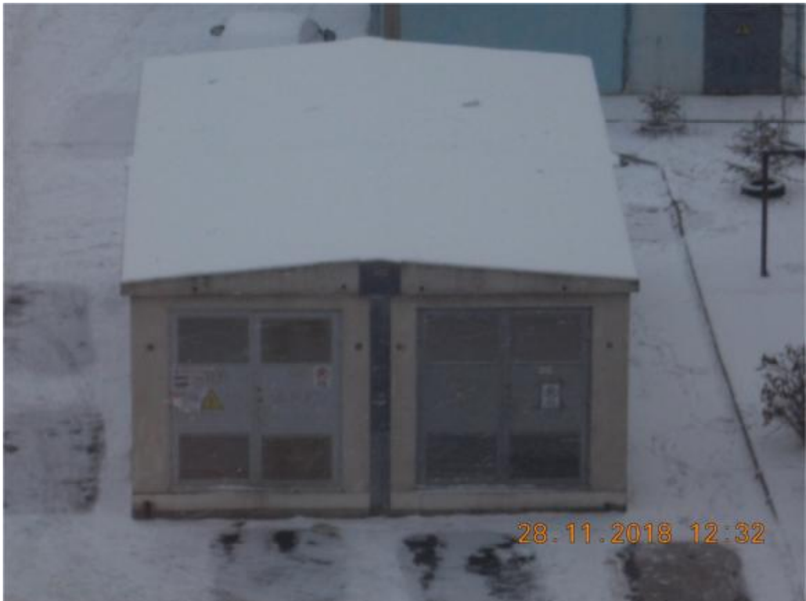
Фото 9. Общий вид здания ТП (фасад)
