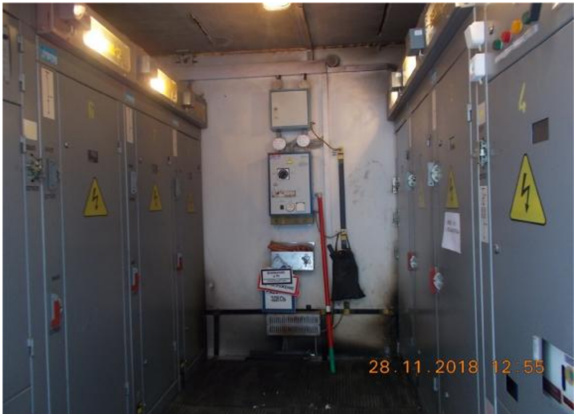
Фото 10. Общий вид здания ТП
