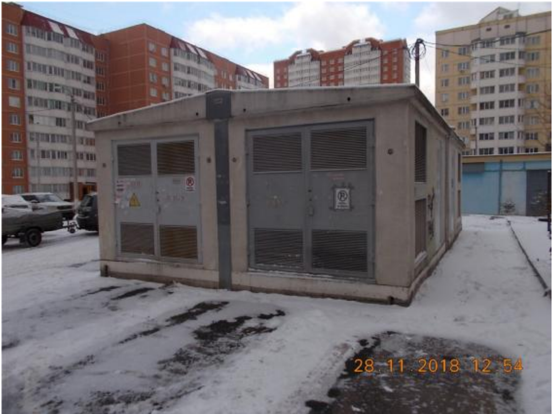
Фото 8. Общий вид здания ТП (фасад)
