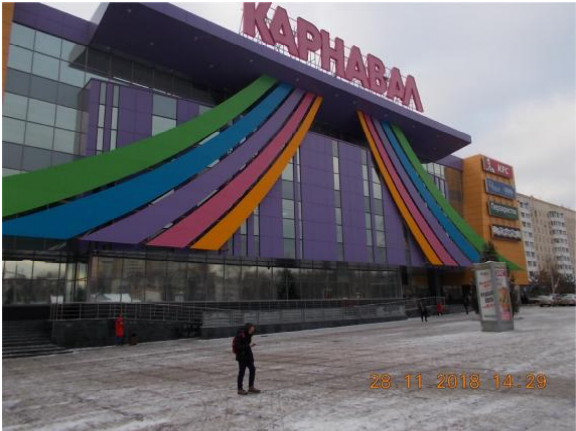
Фото 1. Лицевой фасад здания
