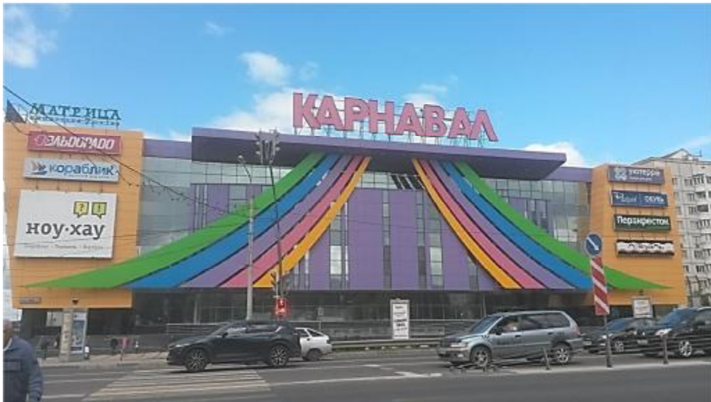
Фото 1. Лицевой фасад здания
