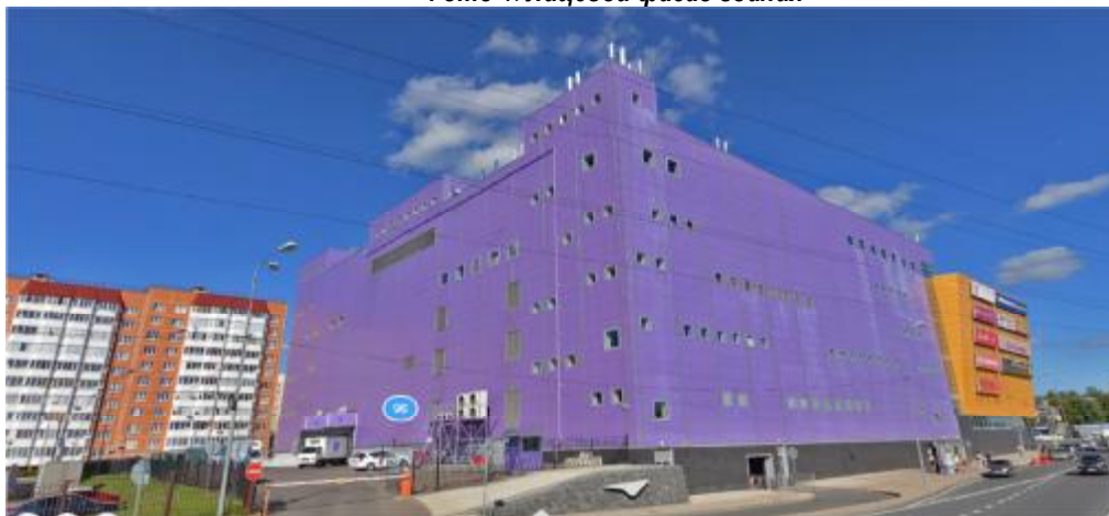
Фото 2. Тыльный и торцевой фасад здания (источник: интернет-ресурсы)
