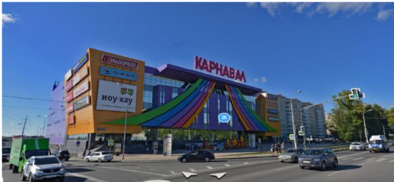
Фото 1. Лицевой фасад здания
