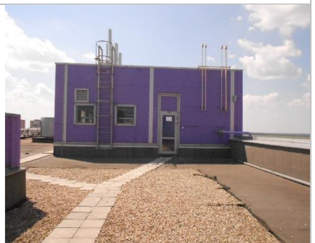
Фото 114. Крыша и тепловой узел.
