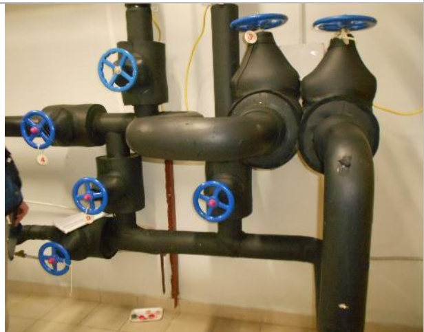
Фото 142. Подз. паркинг и тех. помещения.
