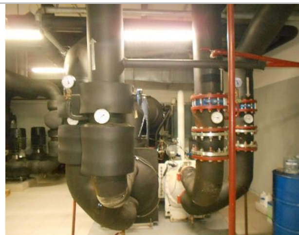
Фото 137. Подз. паркинг и тех. помещения.
