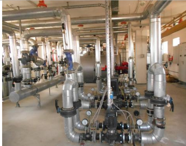
Фото 116. Крыша и тепловой узел.
