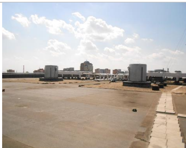
Фото 122. Крыша и тепловой узел.
