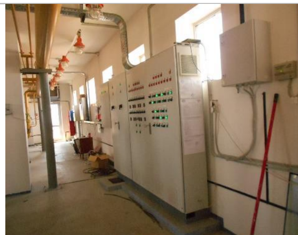
Фото 21 Крыша и тепловой узел.
