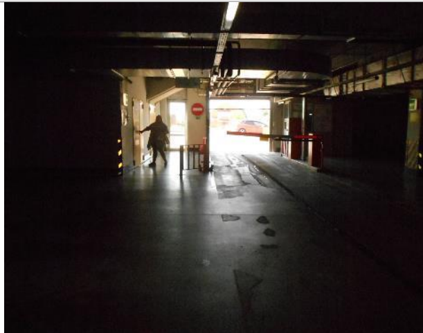
Фото 129. Подз. паркинг и тех. помещения.
