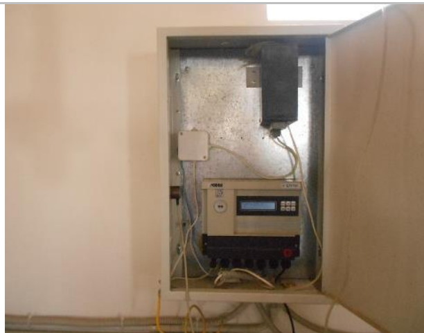
Фото 120. Крыша и тепловой узел.
