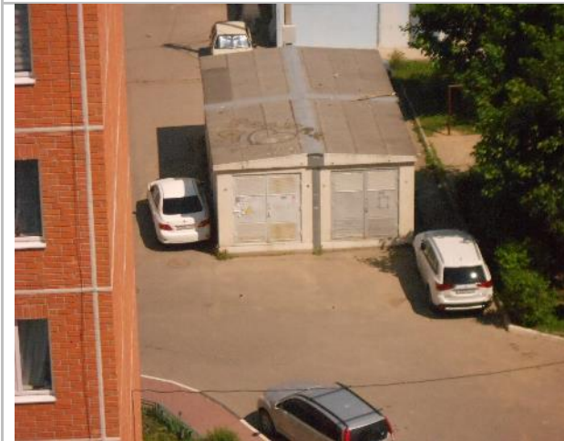
Фото 159. Трансформаторная подстанция (оцениваемый объект №2).
