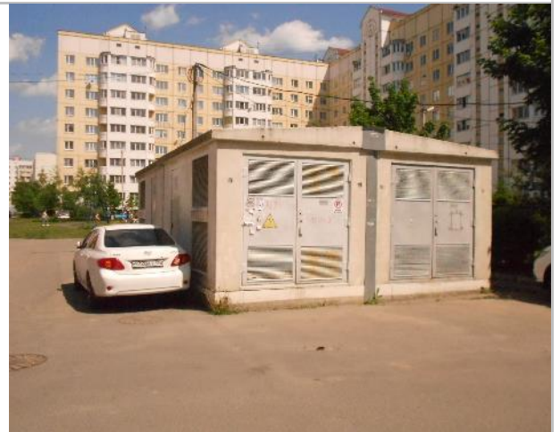
Фото 160. Трансформаторная подстанция (оцениваемый объект №2).
