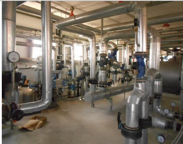
Фото 117. Крыша и тепловой узел.
