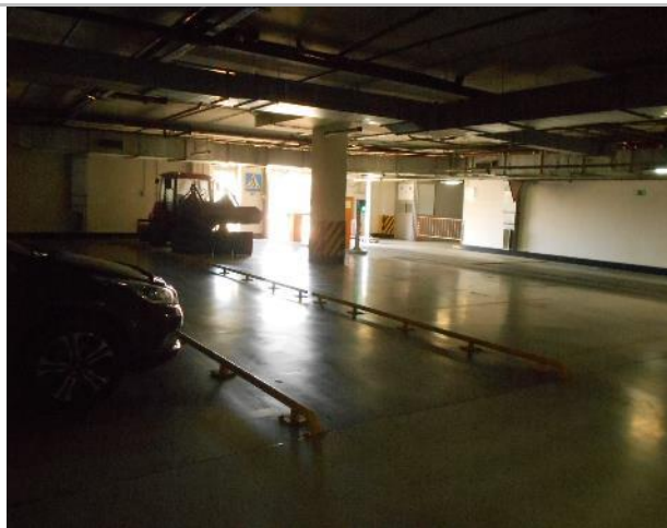
Фото 131. Подз. паркинг и тех. помещения.
