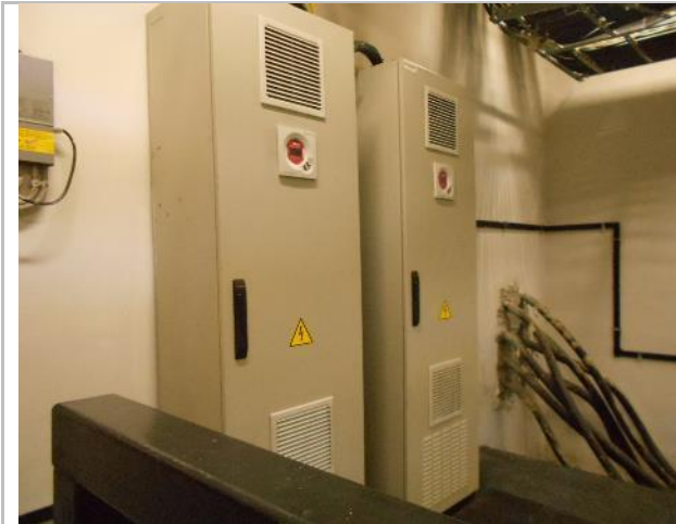
Фото 139. Подз. паркинг и тех. помещения.
