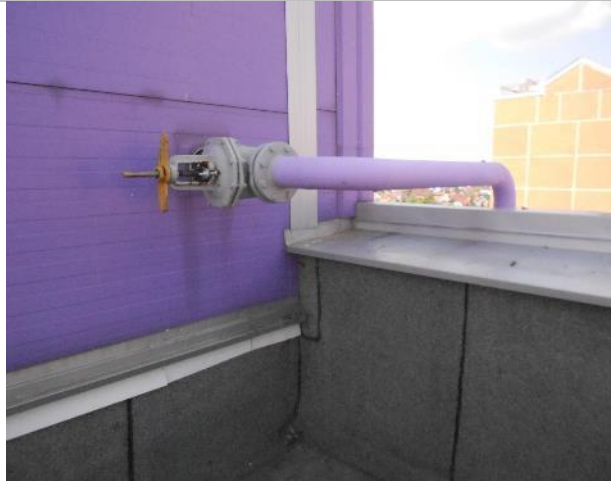
Фото 115. Крыша и тепловой узел.
