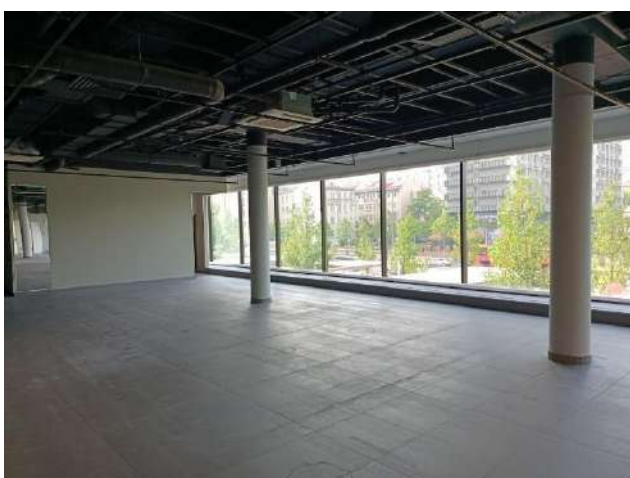
Фото 19. Состояние помещений на 2 этаже
