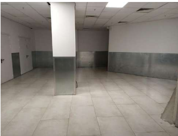
Фото 37. Состояние помещений подвал, -2 этаж
