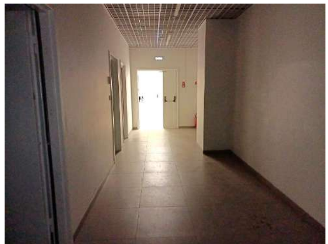
Фото 26. Состояние помещений на 2 этаже
