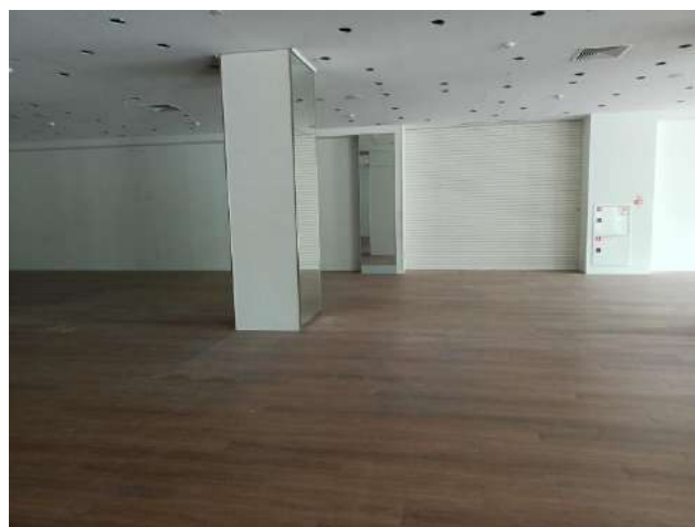
Фото 16. Состояние помещений на 1 этаже
