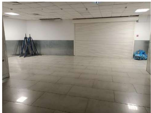
Фото 38. Состояние помещений подвал, -2 этаж
