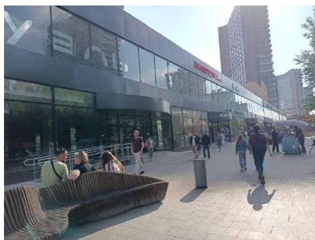
Фото 8. Внешний вид здания, вход в помещения
