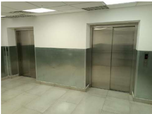
Фото 29. Состояние помещений подвал, -1 этаж
