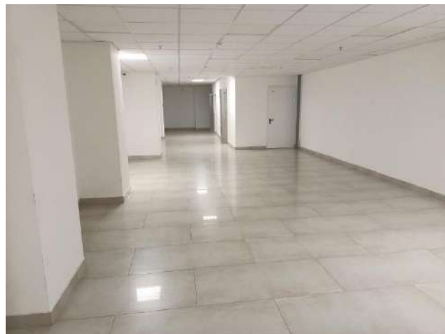
Фото 18. Состояние помещений на 2 этаже
