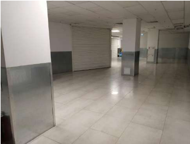
Фото 35. Состояние помещений подвал, -2 этаж
