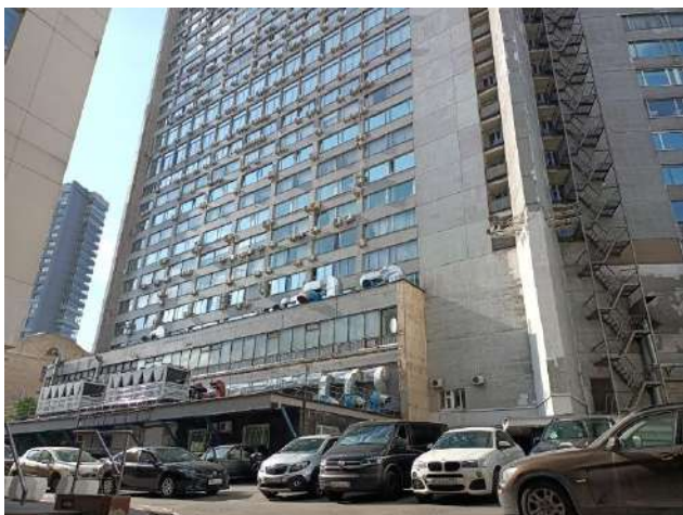
Фото 3. Внешний вид здания
