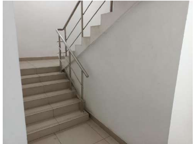
Фото 36. Состояние помещений подвал, -2 этаж
