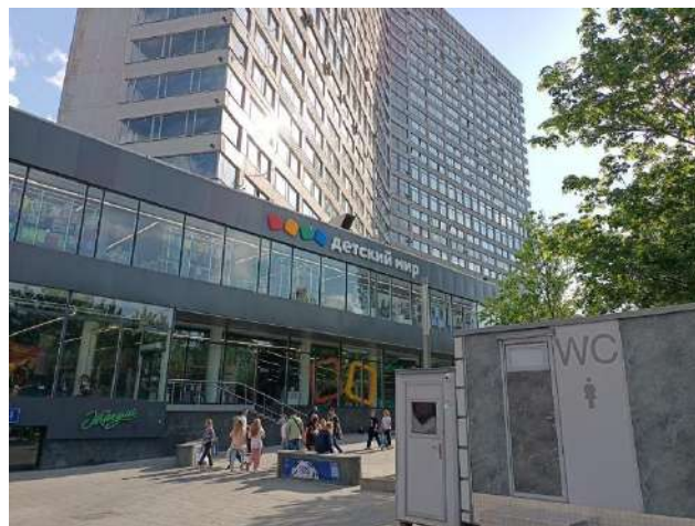
Фото 2. Внешний вид здания
