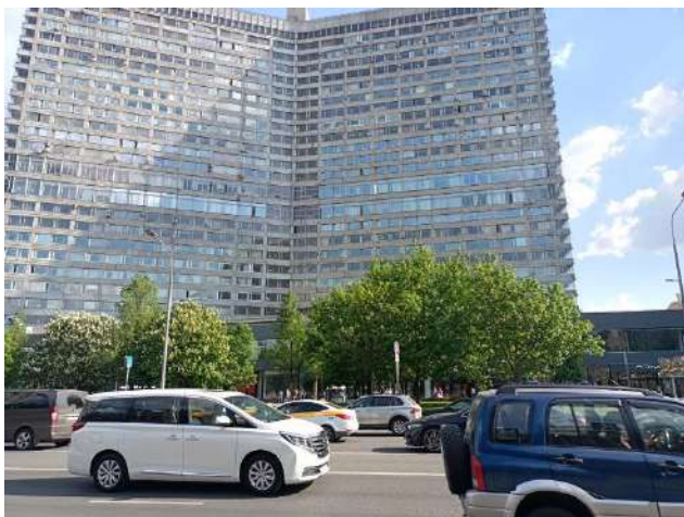
Фото 1. Внешний вид здания
