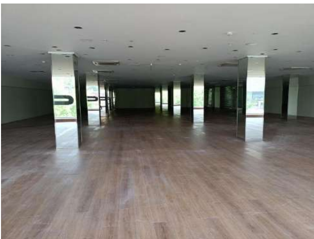
Фото 25. Состояние помещений на 2 этаже
