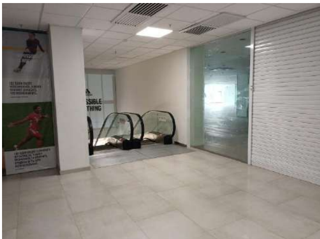
Фото 17. Состояние помещений на 2 этаже
