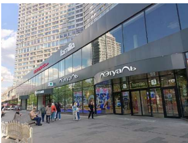
Фото 7. Внешний вид здания, вход в помещения
