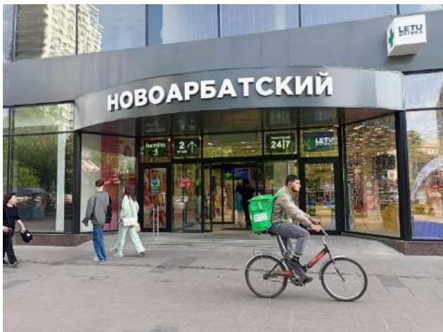
Фото 5. Внешний вид здания, вход в помещения
