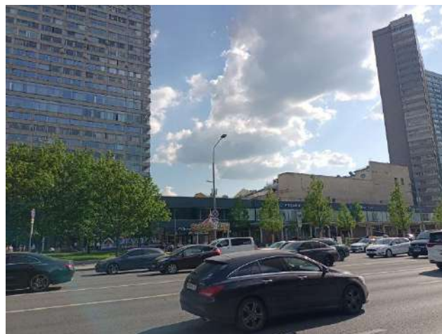
Фото 4. Внешний вид здания
